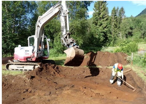
Figur 12 Maskinell flateavdekking ved vestsiden av lok 1.
