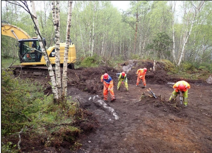
Figur 11. Foto av maskinell avdekking på lok 3, sett mot nordvest.
