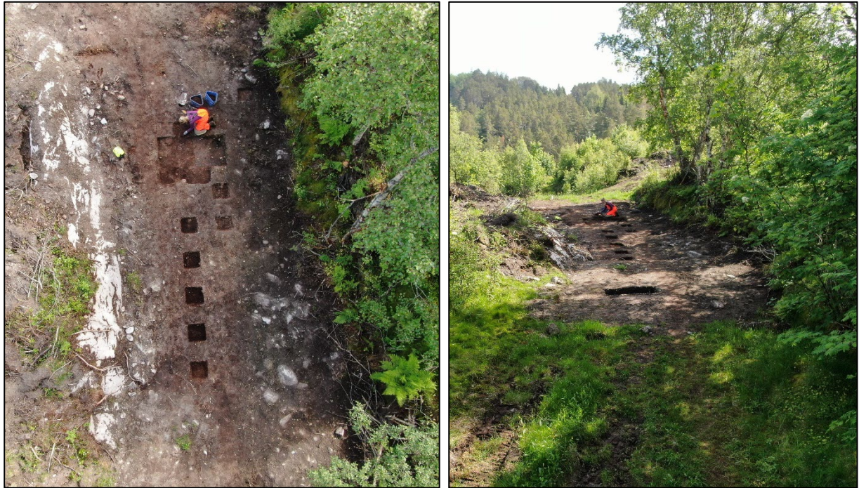
Figur 31. Dronefoto av Lok 2 sett mot øst..
