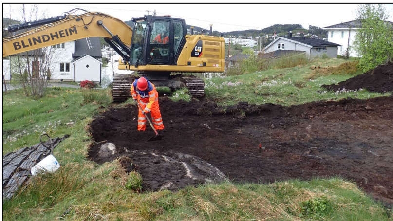
Figur 14. Utgravingsfeltet på Lok 6 lå inntil bergknausen i nedre billedkant. Sett mot nordvest.
