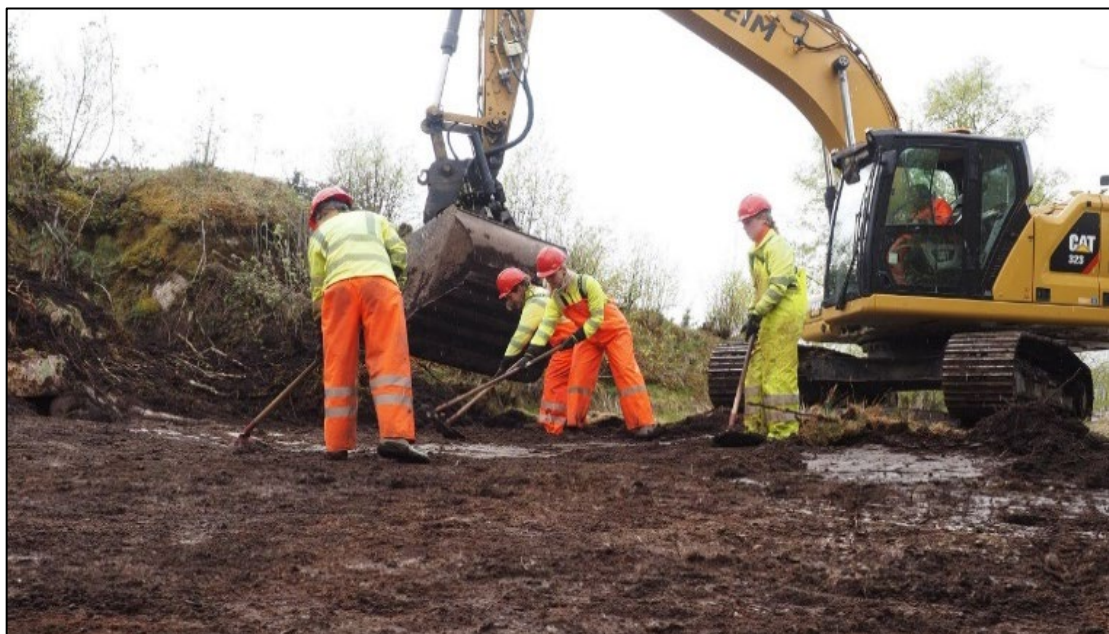
Figur 6. Foto av maskinell avdekking på lok 1. Sett mot sørvest.
