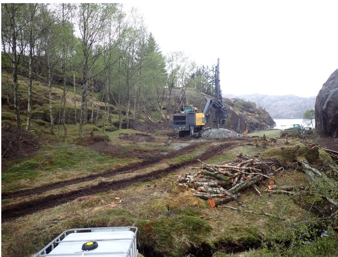
Figur 9. Foto mot nordvest. Lokalitet 2 lå ved en bergknaus som var klar til å sprenges vekk da undersøkelsen startet opp, under og like i forkant av anleggsmaskinen på bildet. Denne måtte flyttes i løpet av undersøkelsen.
