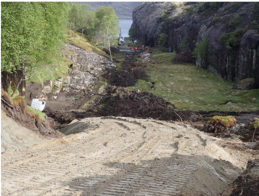
Figur 8. Foto mot nord/nordvest fra Djupvika, med halvbygd anleggsvei, IBC-tank og oransje arkeologer i sving på Lokalitet 2 i bakgrunnen.
