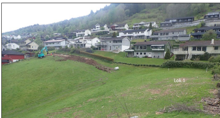
Figur 7. Lok 1 til høyre i bildet, avgrenset av hvite pinner mens arbeid pågår på Lok 2. Bilde tatt mot nordvest.
