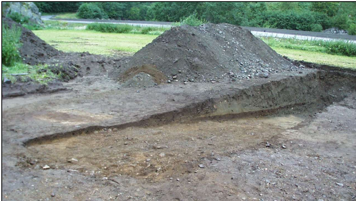
Fig. 29. Profilgrøft A med profil A blev gravet igennem erosionslag på lokalitetens østlige del. Den ses her mod nordvest. Foto UiB.
