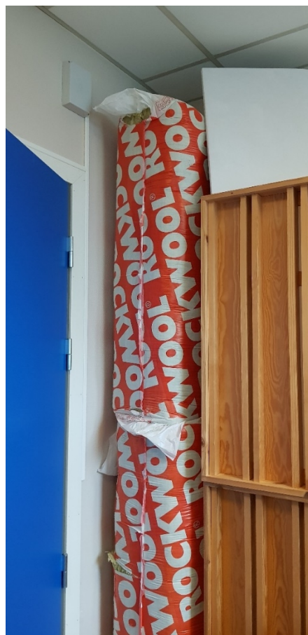
Bilde 2: Glava isolasjon, trekonstruksjon med glava på baksiden, tynne plater for demping på toppen
