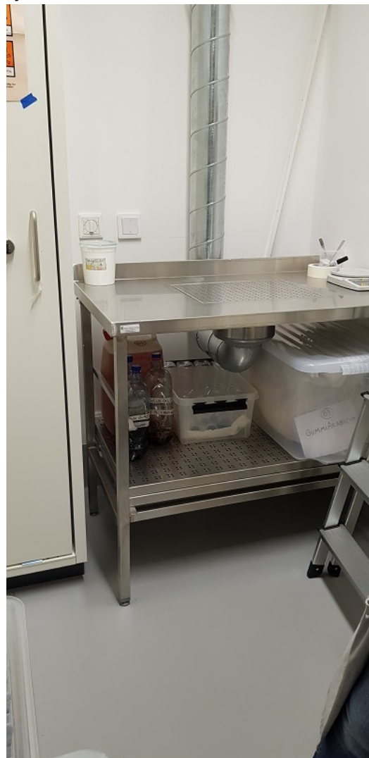
Bilde 9. underventilert benk, og kjemikalieskap til lagring av farlige kjemikalier.
