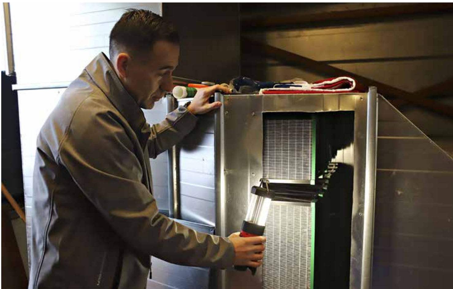
HINDRER FUKT: Guillermo Berger fra Bravida ser inn i et ventilasjonsanlegg for å sjekke om det er fuktskader.
