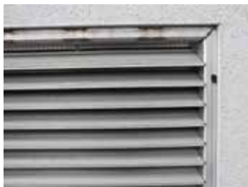
GAMLE RISTER: Utgangen på ventilasjonsanlegget i Gjensidige-gården har fortsatt gamle rister. Her er det større mellomrom og større mulighet for at vann kan trenge inn.
