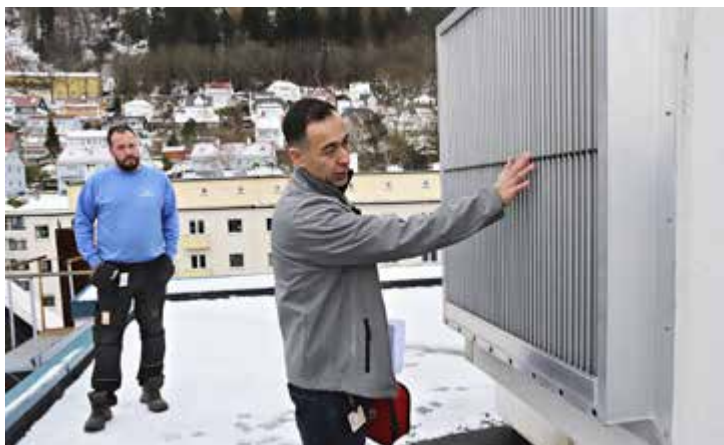
TETT: Blant byggene i Bergen som har fått offshore-rister er Gjensidige-gården i Sandviken. Ristene er mye tettere enn tradisjonelle rister.
