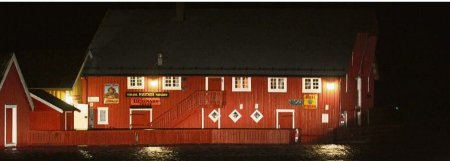
Hopsjøbrygga på Melandsjø ble for første gang i manns minne oversvømmet i 2011, og flere andre bygninger i øyregionen ble oversvømmet. Men verre skal det bli.
