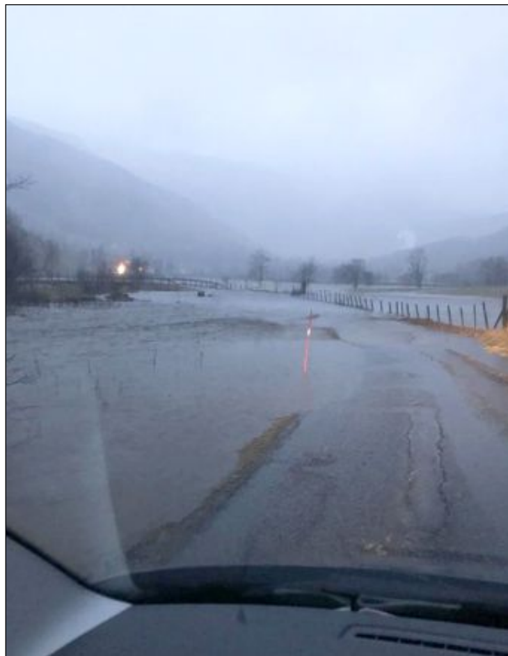
Vegen inn mot Øyno var på visse stader heilt oversvømt av vatn. Foto: Eirik Molland, Etne kommune
