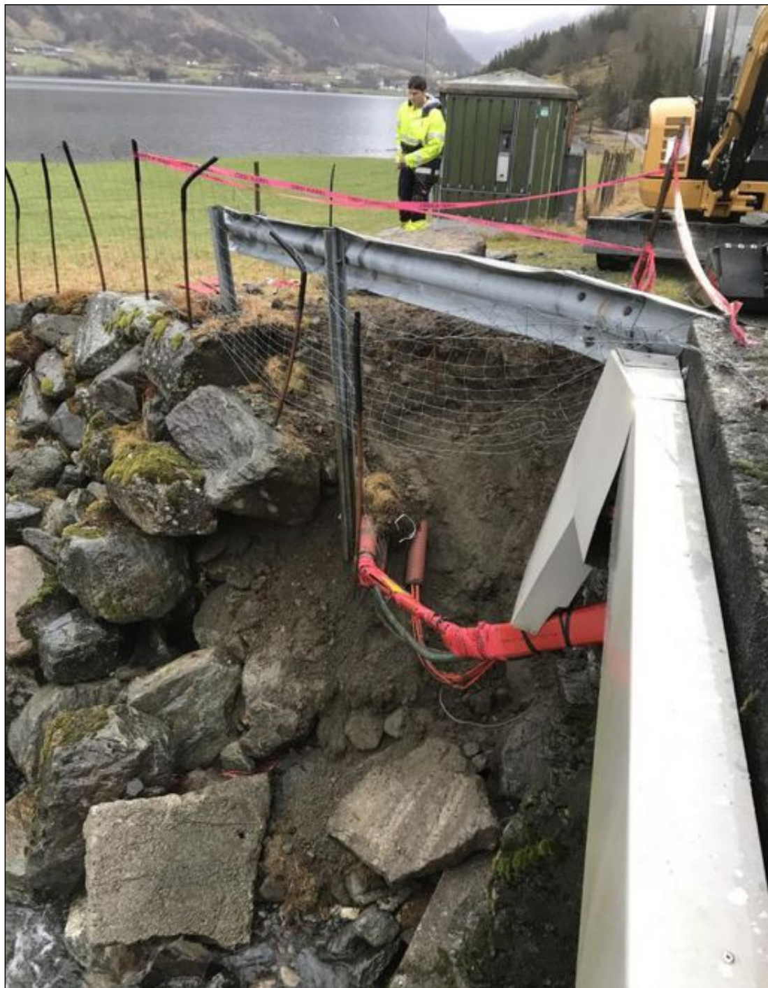
Dagleg leiar i Etne elektrisitetslag, Einar Arefjord hadde vakt i julehelga og her på Flåte har vatnet grove seg under vegen slik at store steinar rasa ut, og straumleidningar kom i klem. FOTO: EIRIK MOLLAND, ETNE KOMMUNE
