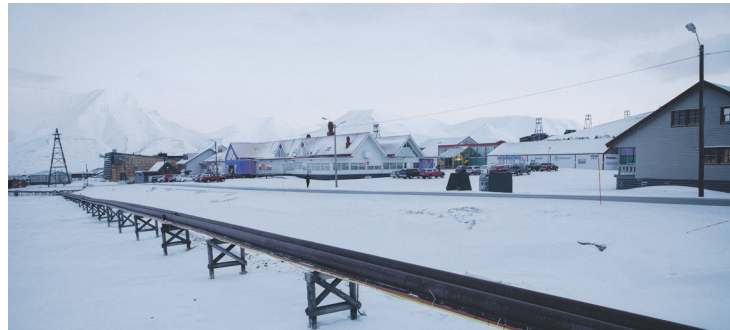
SVALBARD: Permafrosten gjør at rør må legges over bakken. Hvis tinedybden øker dramatisk i årene som kommer, vil det få betydning for bebyggelse, veier og vannledninger. Foto: Tore Meek, NTB scanpix
