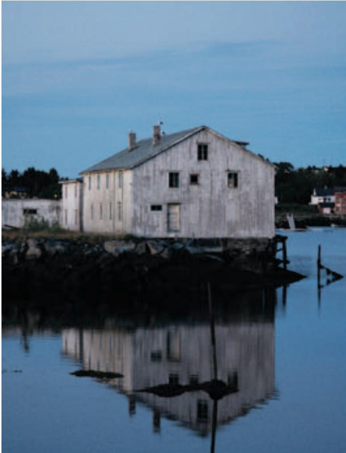
KLIMATILPASNING: I framtiden må mange bygninger forlates eller flyttes lenger inn på land på grunn av havstigningen. Noen kommuner har begynt planlegging og klimatilpasning med tanke på at havet kommer nærmere innpå oss. (FOTO: Bjørn Hugo Pettersen)
