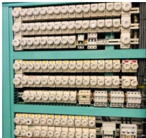
Figur 7 Underfordeling i nordfløy i Fysikkbygget.
