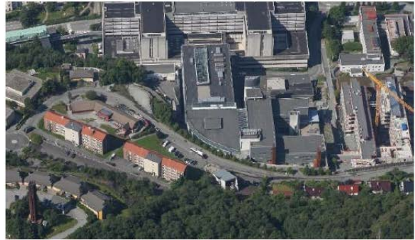
Området med påbygg. Påbygget passer godt inn i eksisterende struktur
