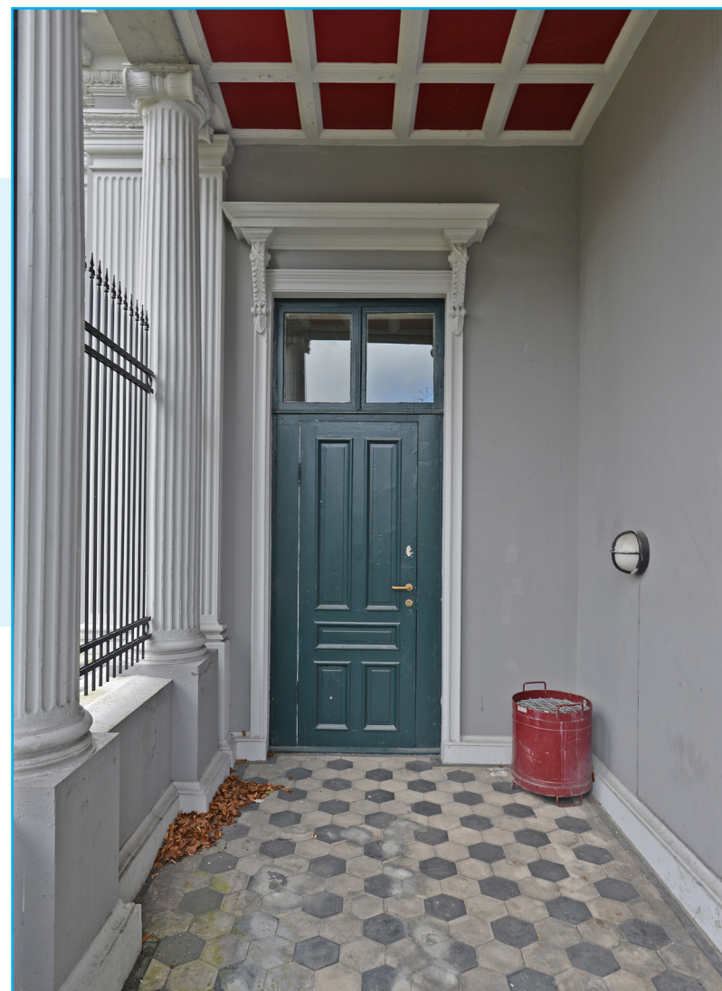
Loggia sett mot dør til hagestue. Foto: EIA
