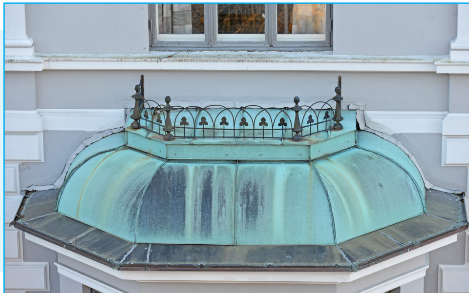
Original smijernsdekor og kobbertekke på karnapp. Foto: EIA
