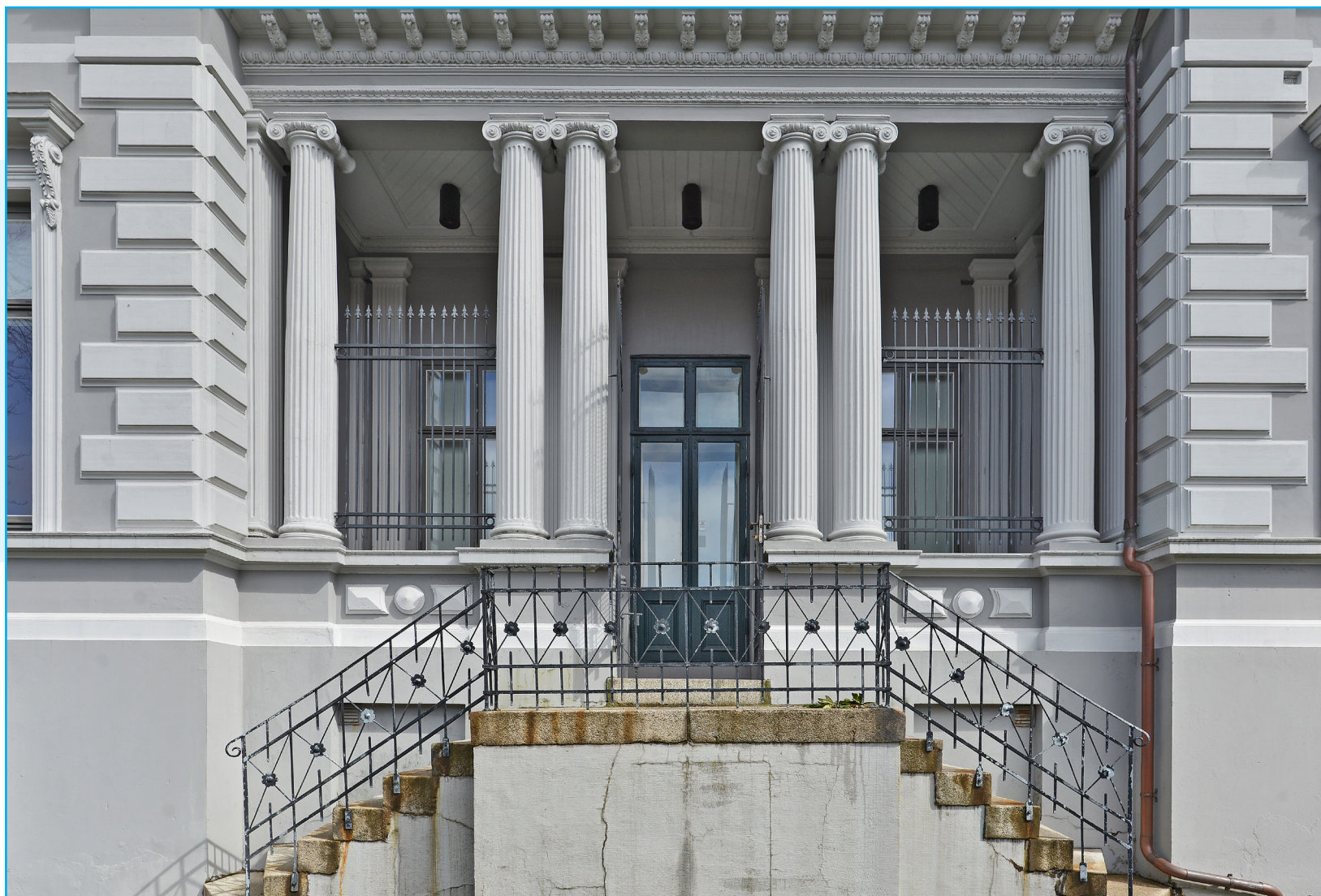
Den store loggiaen mot hagen er godt bevart og et viktig motiv i vestfasaden. Foto: EIA
