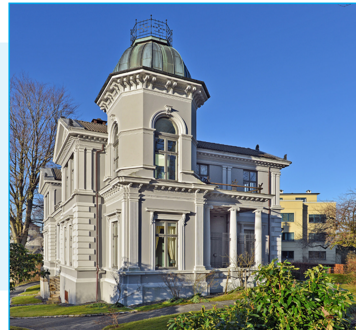
Fasade mot sør. Tårnrom med oktagonalt kobberkuppel. Foto: EIA
