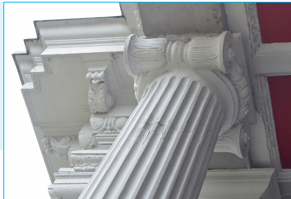
Mye dekor ble reparert og rekonstruert under rehabiliteringen av villaen i 1996. Foto: EIA
