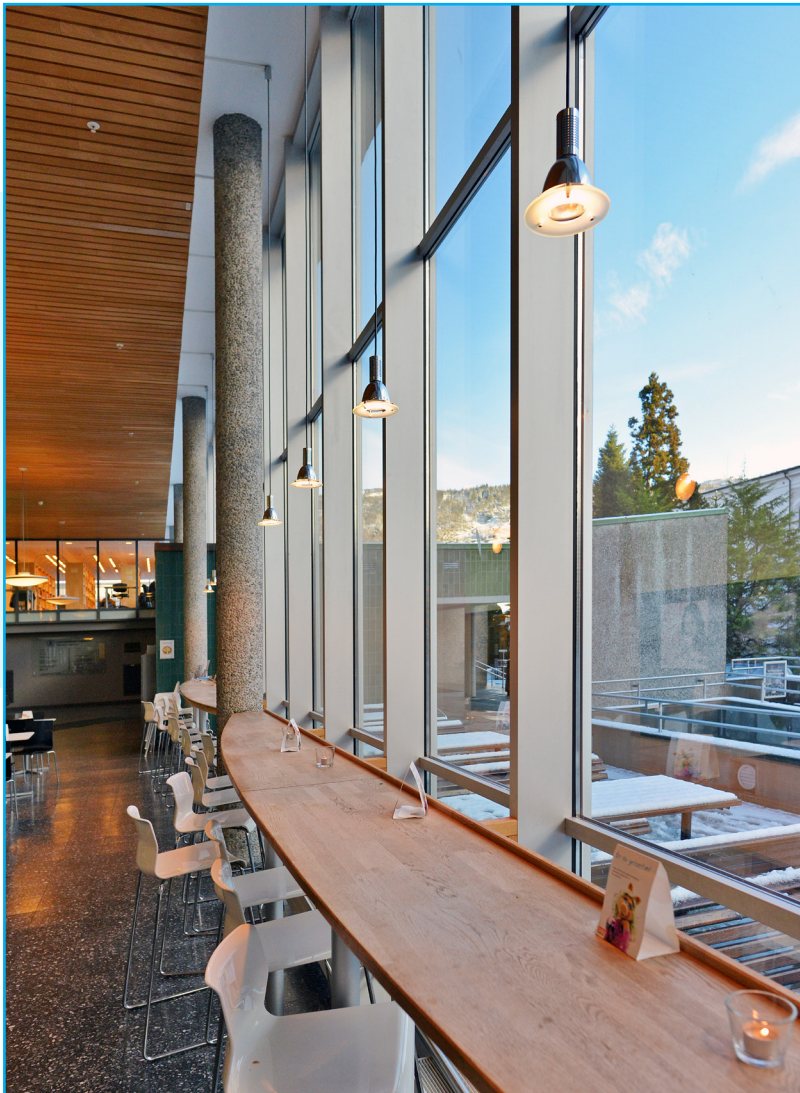
De bærende betongsøylene blir eksponert i vestibulen. Foto: EIA
