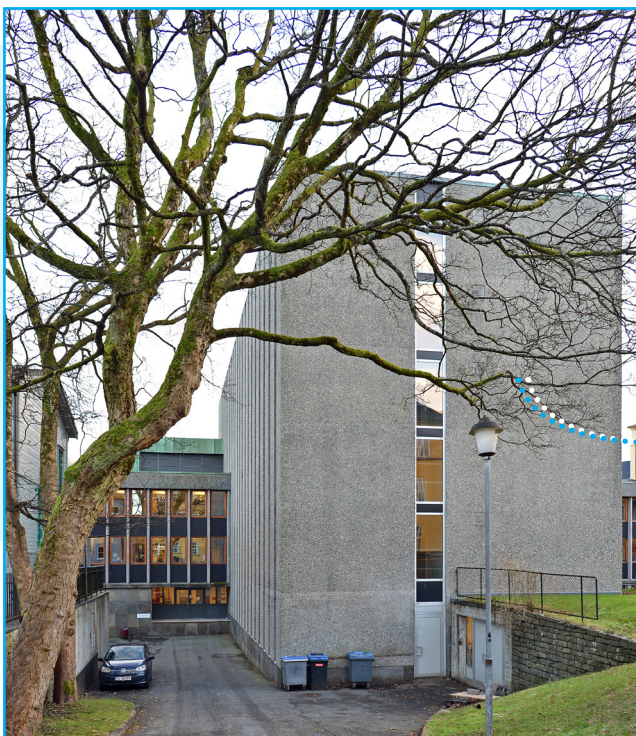
Fra nord troner boktårnet ved nedkjørselen til bibliotekets tekniske område med personalinngang, lasterampe og garasje. Foto: EIA
