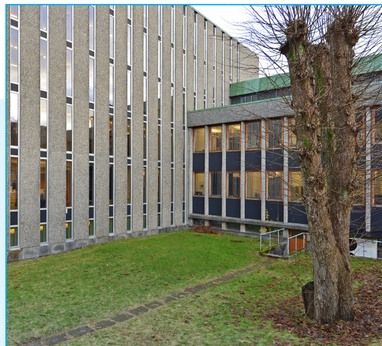
Gangvei over plenen til dør i kjeller, nordvest. Foto: EIA
