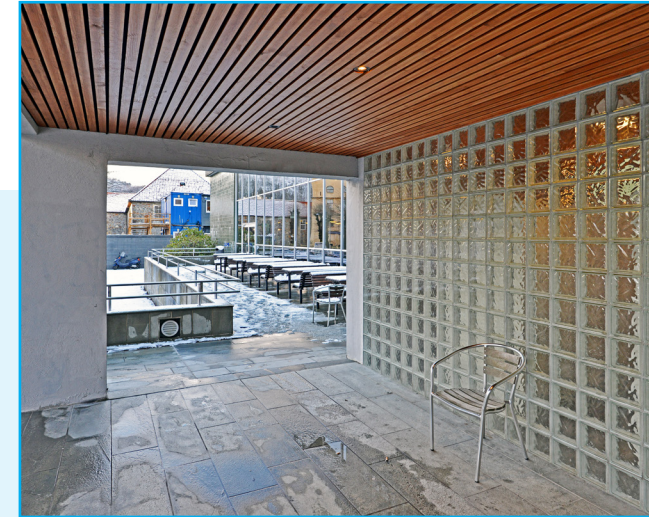
Ytre vindfang. Foto: EIA
