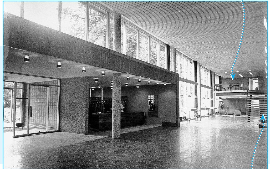
Vestibulen slik den fremstod da biblioteket var nytt. Dører er byttet og noen vegger ved inngangen har fått ny posisjon, men mange originale bygningsdeler som fliser på gulv og vegger er intakt. Foto: Knut Strand, Bergens Tidende
