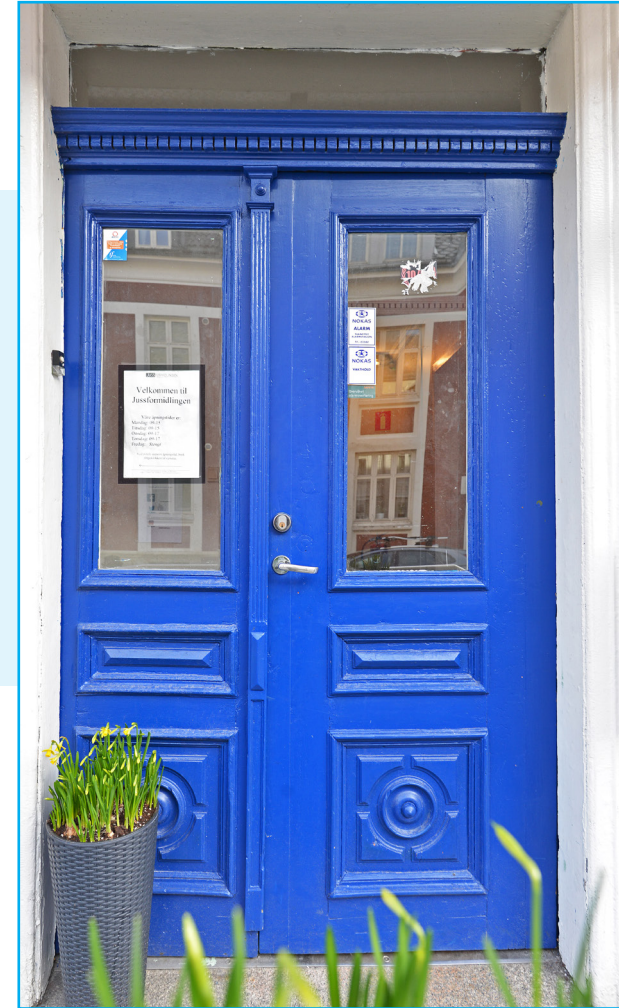
Original inngangsdør Sydneshaugen 10. Eldre grønnfarge er overmalt. Foto: EIA
