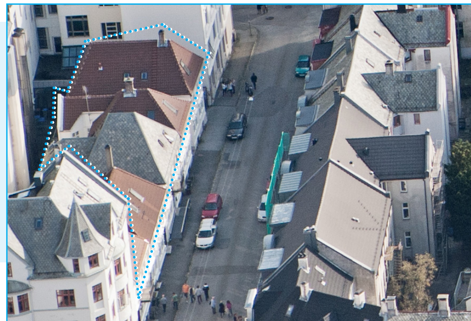
Alle trehusene har trolig opprinnelig hatt pannetak unntatt Sydneshaugen 10 som har tak med lappskifer intakt. På dette huset har etterisolering gitt taket brattere takvinkel. Foto: Alf Edgar Andresen, UiB 2011
