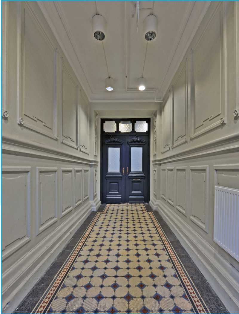
Sydnesplassen 13 har et uvanlig stort, påkostet og godt bevart vindfang med originale fliser, dekorerte veggflater og utsmykket himling intakt. Både den doble ytterdøren og den tilsvarende døren inn mot husets hall er originale og har en særdeles flott utførelse. Foto: EIA
