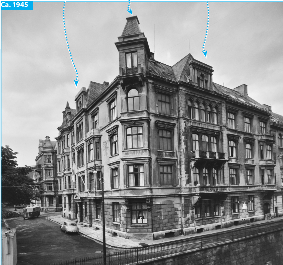
Mer av dekoren har blitt borte fra fasaden på Sydneplassen 13. Spir på tak, utsmykning under vinduer og akroterion over gavl mot sør er fjernet. Foto: Norvin Reklamefoto, Universitetsbiblioteket i Bergen
