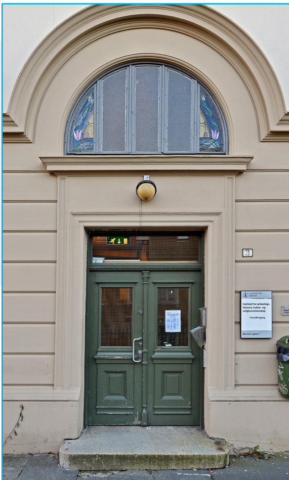
Original inngangsdør Øysteins gate 3. Alle foto: EIA
