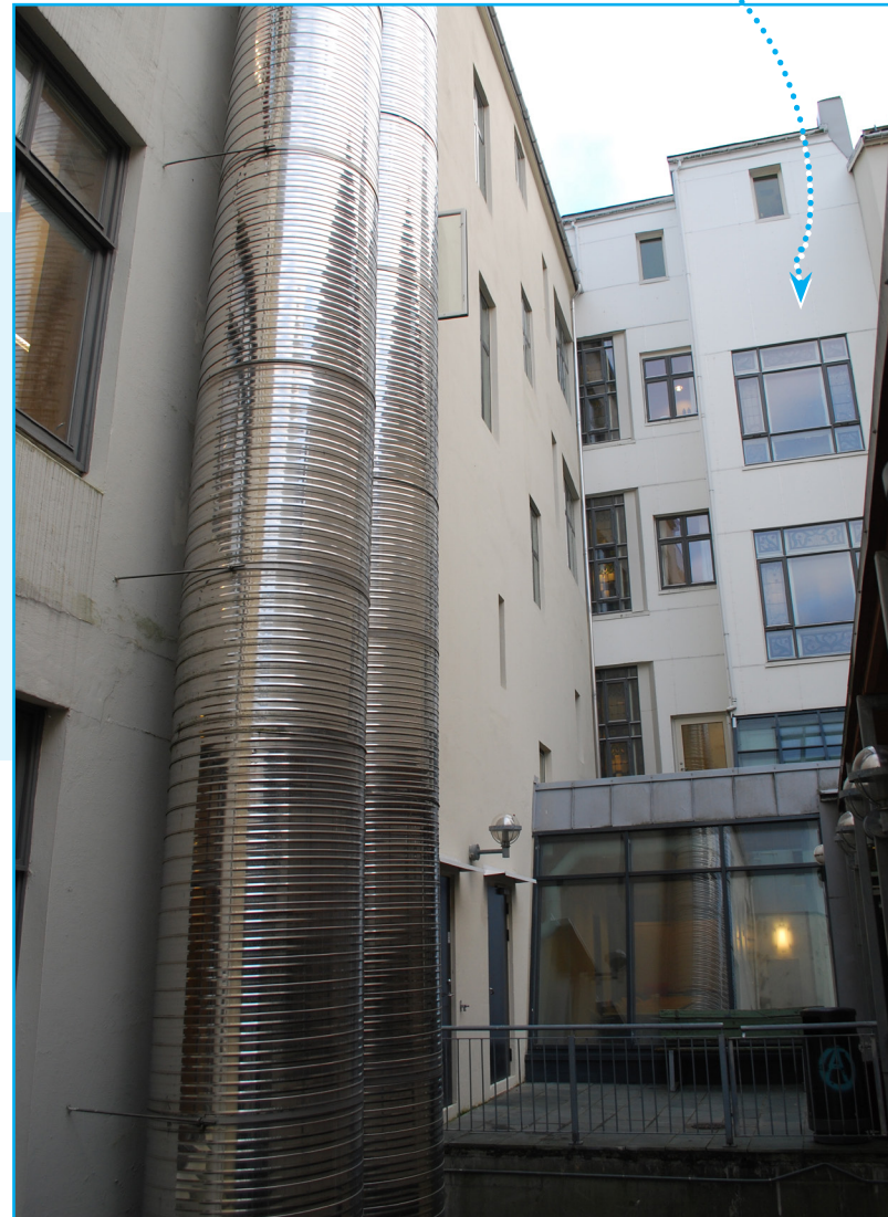
Bakfasaden til Sydnesplassen 13, sett fra nord. Foto: EIA
