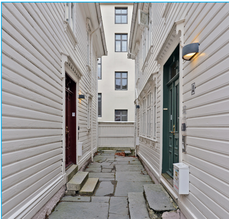
Smuget mellom Sydneshaugen 12 og 14. Foto: EIA
