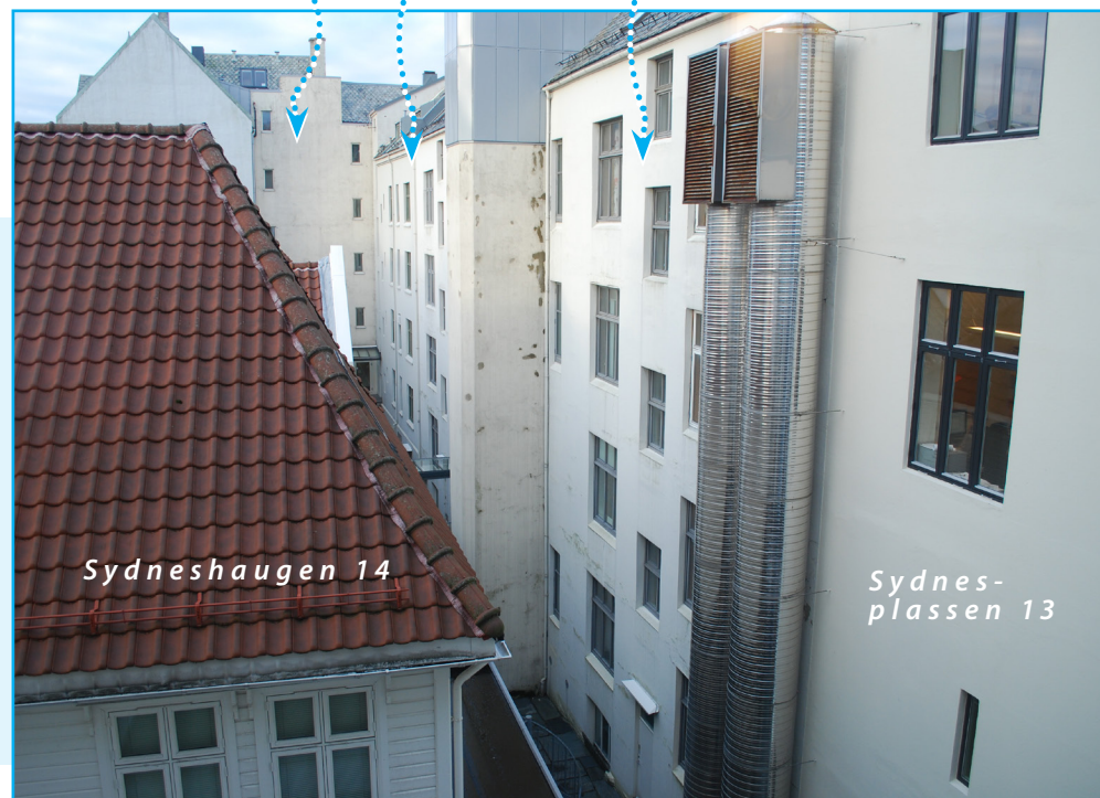
Bakfasaden til (fra høyre) Sydnesplassen 13, Øysteins gate 3, Øysteins gate 1 og Dokkeveien 2 B sett fra sør. Foto: EIA
