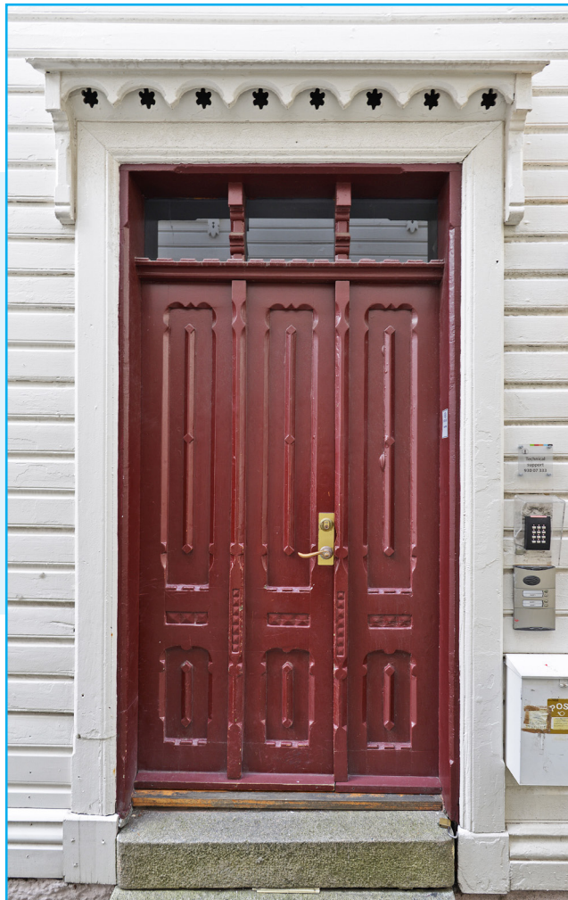
Original inngangsdør Sydneshaugen 12. Eldre okerfarge er overmalt. Foto: EIA
