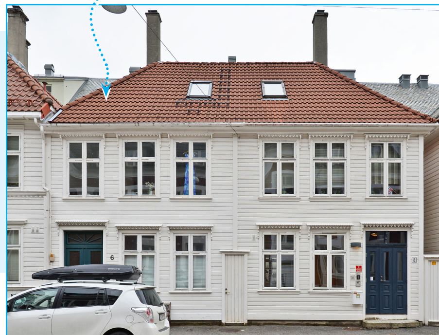
Fasade Sydneshaugen 6 (privateid) og Sydneshaugen 8. Original kledning og listverk. Foto: EIA
