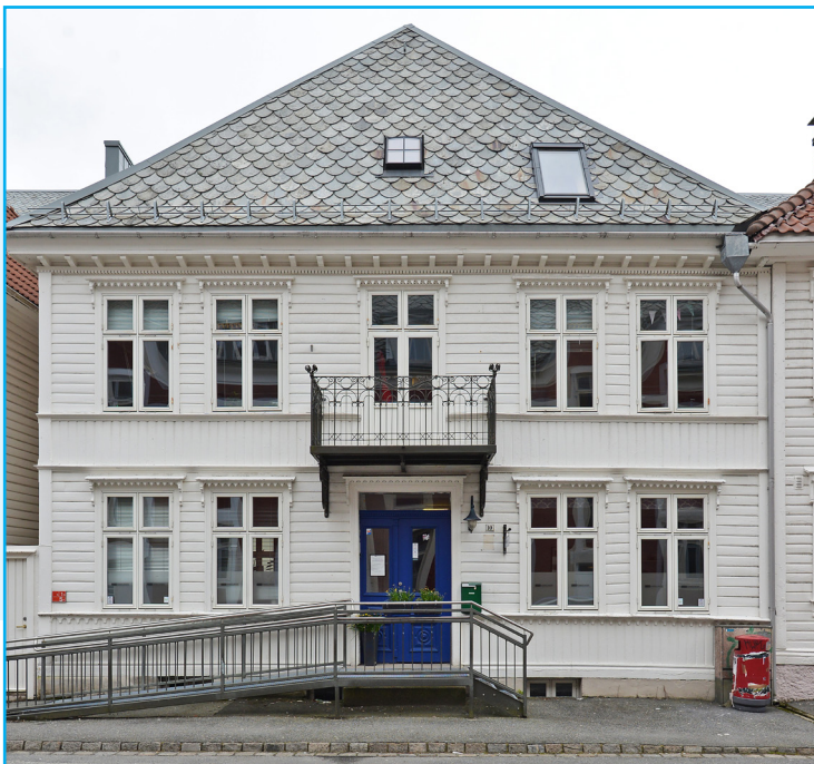
Fasade Sydneshaugen 10. Originalt smjern, original kledning og listverk, dør og skifer. Foto: EIA
