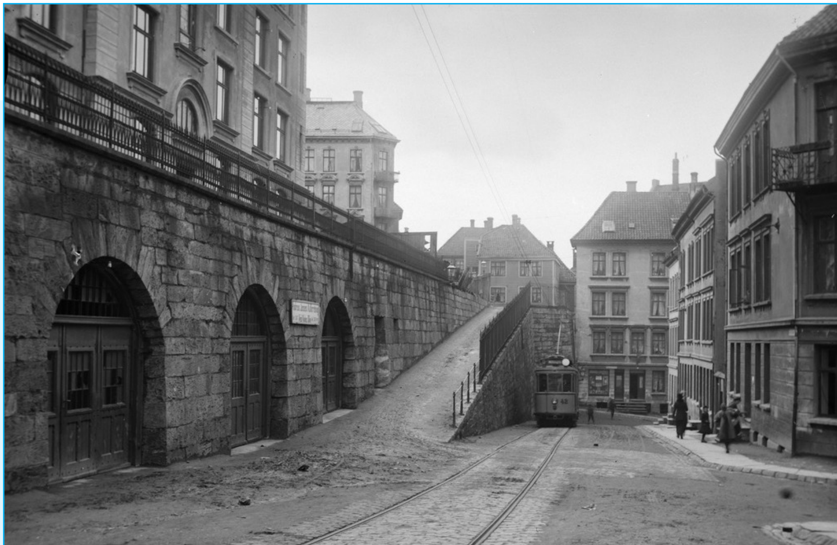
Kjellerrommene under Øysteins gate 3 og Sydneplassen 13 hadde opprinnelig inngang gjennom tredelte fyllingsdører. De buede åpningene i muren er på nivå med Øysteins gate nedre løp. Foto: Olai Schumann Olsen ca. 1915, Universitetsbiblioteket i Bergen
