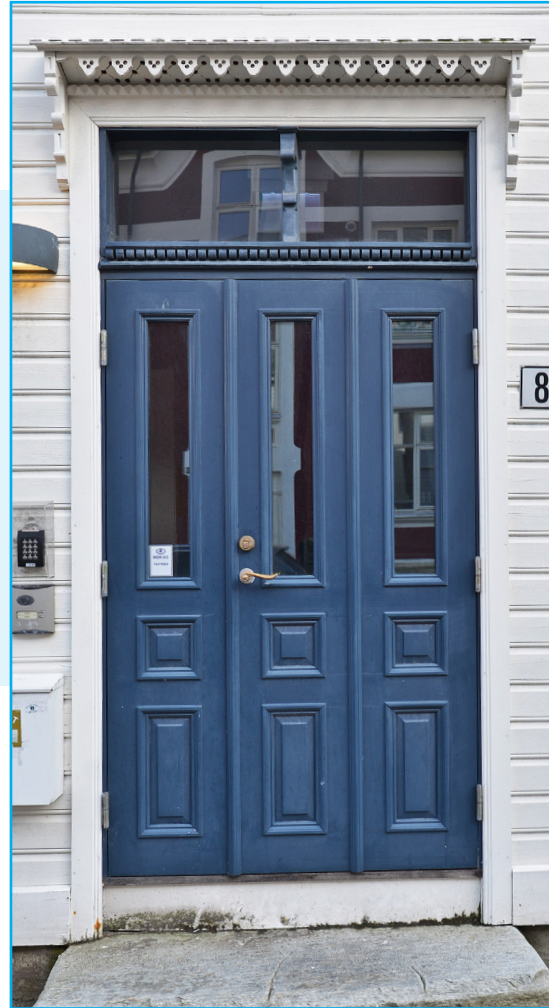
Kopi av eldre inngangsdør Sydneshaugen 8. Originalt overlys. Foto: EIA
