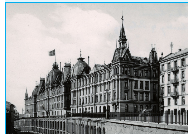
Det eksklusive boligkomplekset Victoria terrasse i Kristiania fra 1885, skal ha inspirert til planleggingen av det nævdalske komplekset. Der var leilighetene fra 240 til 460 kvadrat. Utenriksdepartementet har holdt til i Victoria terrasse siden 1905. Trappeløpene er fredet. Basarhallene under anlegget er revet. Foto: Tilhører Riksantikvaren
