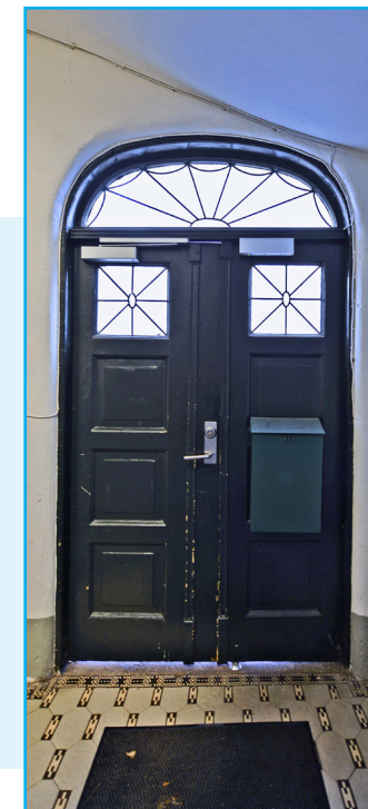
Original inngangsdør Dokkeveien 2 B. Foto: EIA
