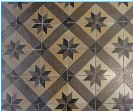
Flisegulv Øysteins gate 3. Foto: EIA
