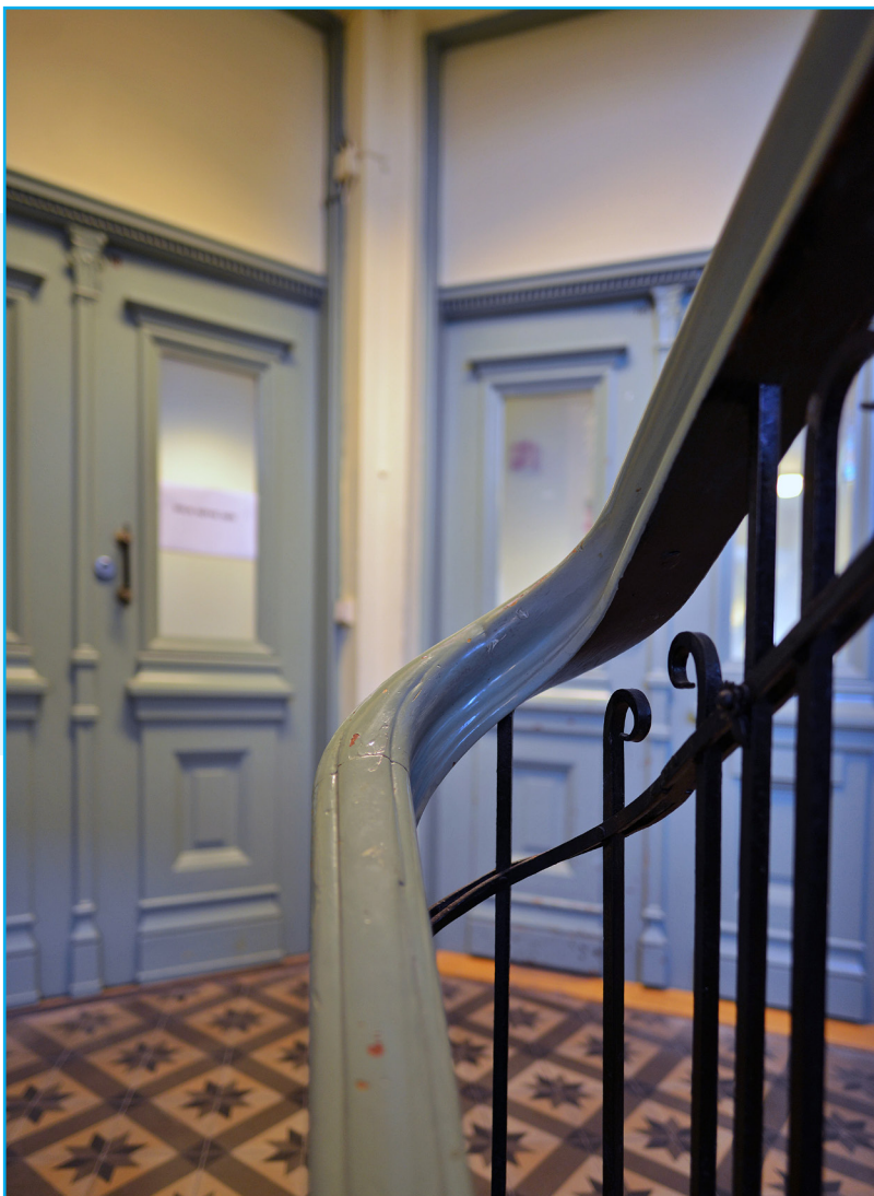
Rekkverk Øysteins gate 3. Foto: EIA
