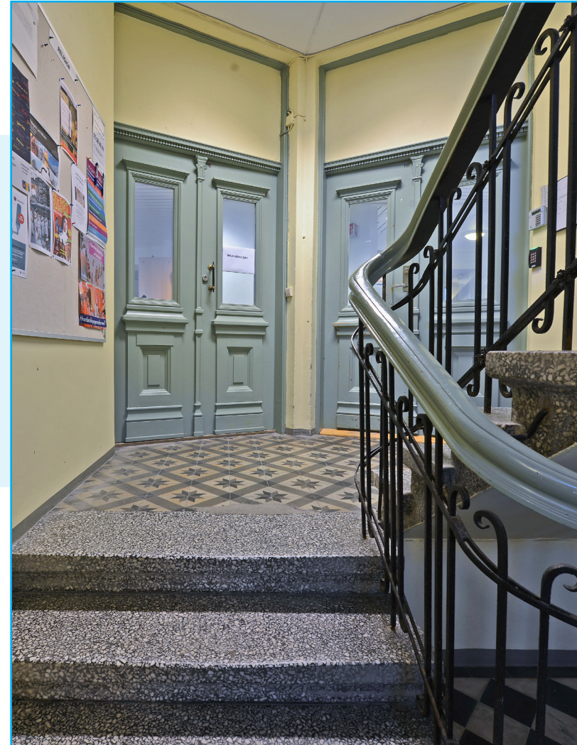
Trapperommet i Øysteins gate 3 er lite endret. Originale doble fyllingsdører er intakt i alle etasjer. Opprinnelig overlys er muligens intakt inni ny vegg. Trapp med rekkverk og gelender er original, det er også fliser på gulv. Foto: EIA
