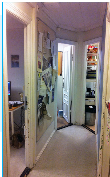
Originale fyllingsdører i 2. etasje Sydneshaugen 10.
