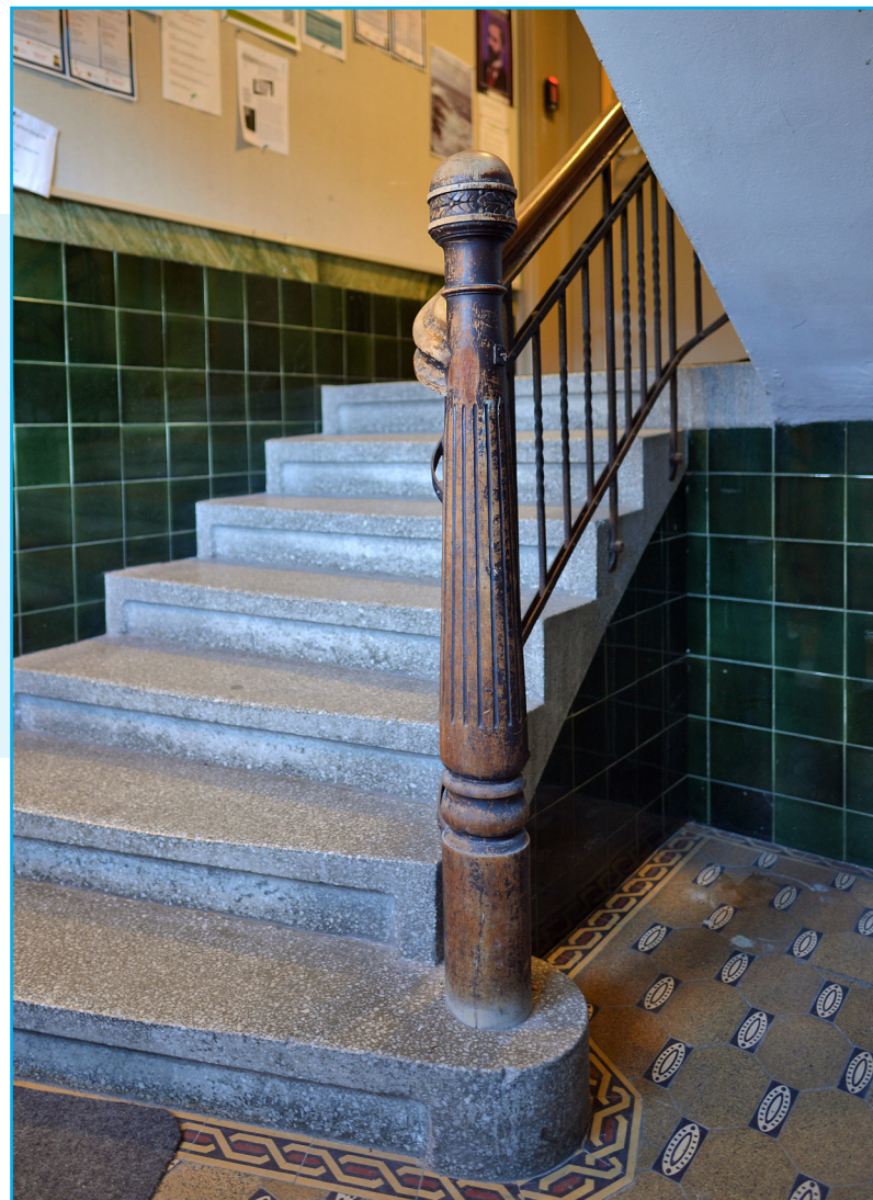
Rekkverk Øysteins gate 1. Foto: EIA
