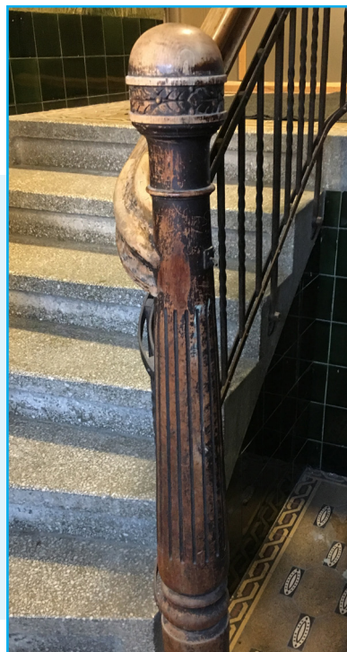
Original trappestolpe i Øysteins gate 1. Foto: b+b arkitekter
