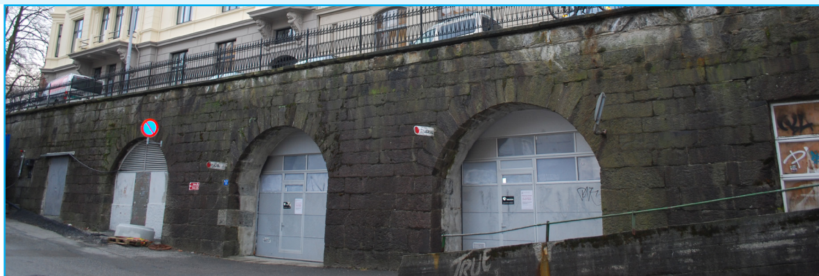
Nye aluminiumsporter erstatter opprinnelige fyllingsdører av tre i inngang til kjeller under Øysteins gate 3 og Sydneshaugkvartalet
