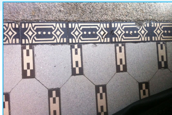
Flisegulv Dokkeveien 2 B. Foto: EIA
