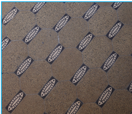
Flisegulv Øysteins gate 1. Foto: EIA
