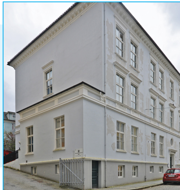
Fasade mot sør. Bilde over til venstre: tilbygg med inngang til trapperom. Dør ikke original. Foto: EIA
