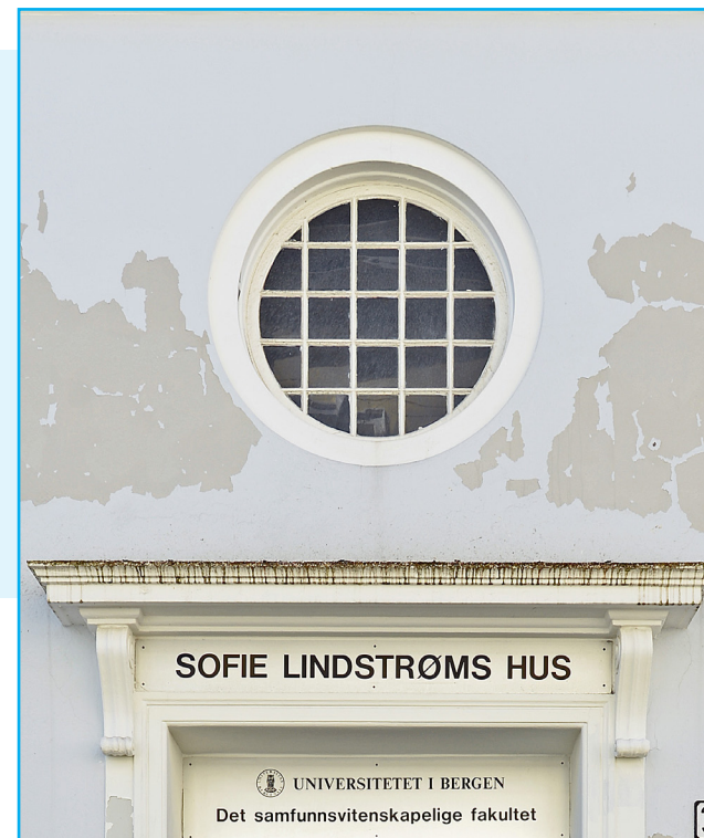
Da Maskinistkolen overtok bygningen, fikk huset nytt inngangsparti og dette runde vinduet. Foto: EIA
