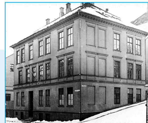
Bilde trolig fra da bygget stod ferdig. (Kilde: «Kommunale skoler i Bergen. Kulturhistorisk rapport om skolebygg fra 1724 til 1979.» Byantikvaren i Bergen 2013.) 1. byggetrinn.
