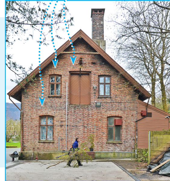
Fasade mot nord. Døren i gavlen og de to vinduene til venstre for denne er originale. Foto: EIA
