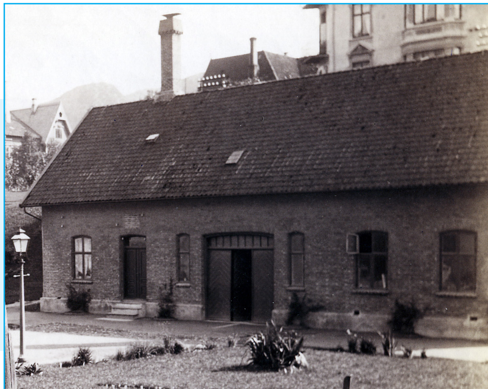
Gartnerbygningen er en teglsteinsbygning som har mange av sine opprinnelige bygningsdeler intakt. Fotograf ukjent, Universitetsbiblioteket i Bergen
