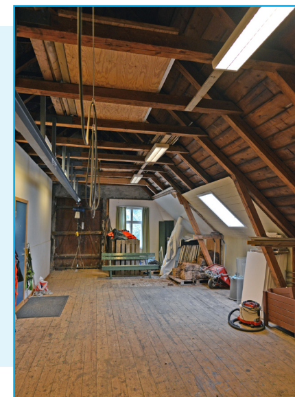
Verkstedet i andre etasje. Foto: EIA
