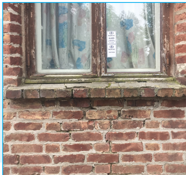
Detalj av skadet tegl, fasade nord. Foto: EIA
