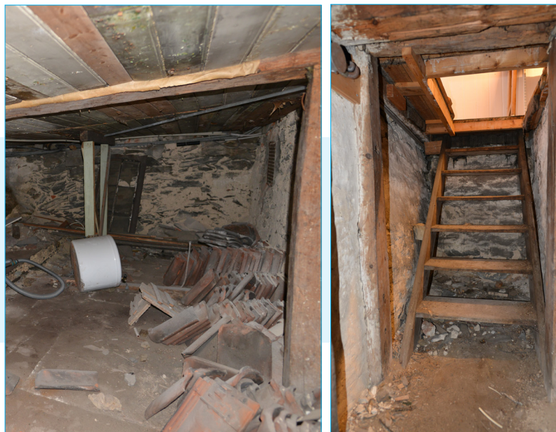
Det er kjeller under halve arkhøyhuset fra 1790. Kjelleren har delvis hellelagt gulv og murt vegg av gråstein mot vest. Foto: EIA
