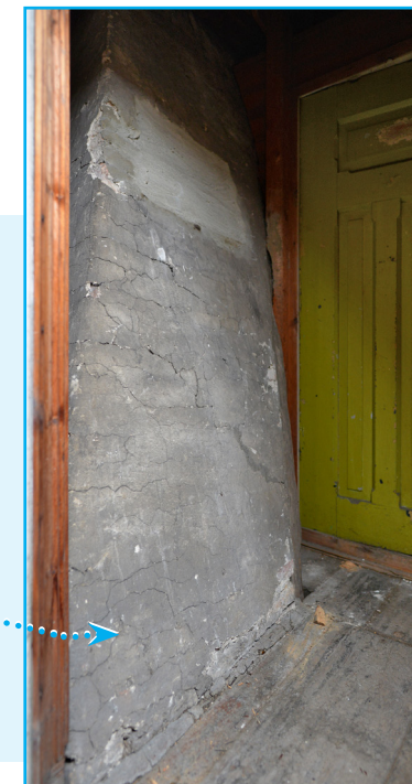
Arkøyhusets originale pipe fra 1791. Foto: EIA
