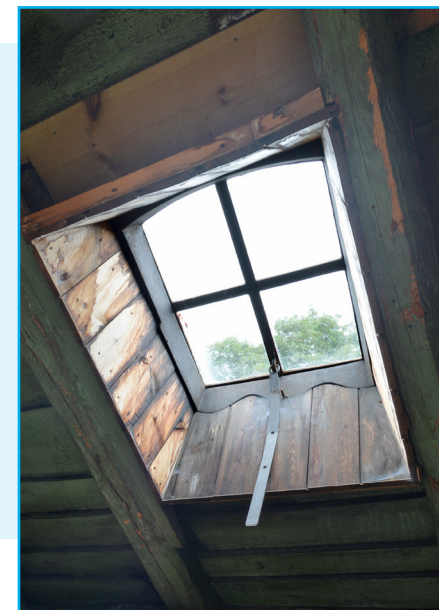
Originalt takvindu i rom 304. Alle konstruktive bygningsdeler i denne etasjen er originale fra 1791. Foto: EIA
