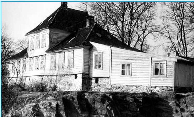
Fasade mot vest 1958 viser deler av utskutt tomt til Bergens sjøfartsmuseum. Foto: Gustav Brosing, Universitetsbiblioteket i Bergen
