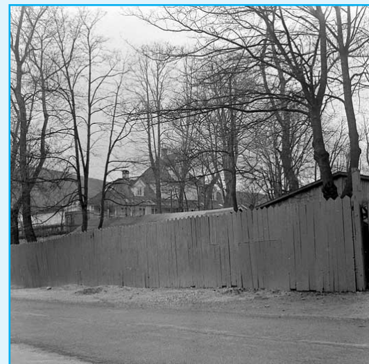
Plankegjerde som omringer eiendommen.
