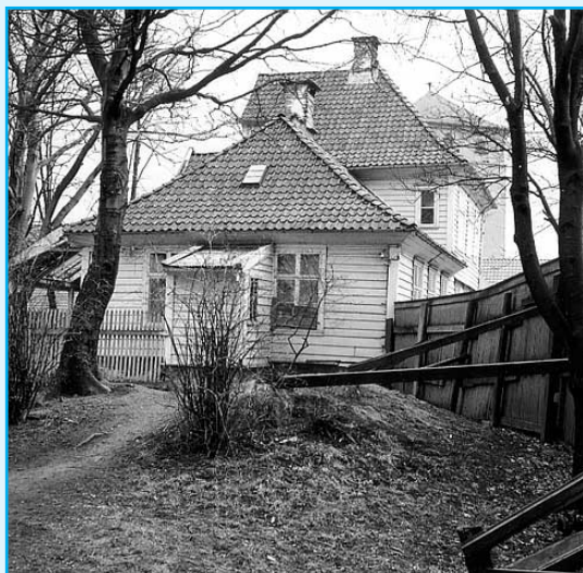
Fasade mot øst og nord, 1962. Asylet er nedlagt, hovedbygningen står ubrukt.
