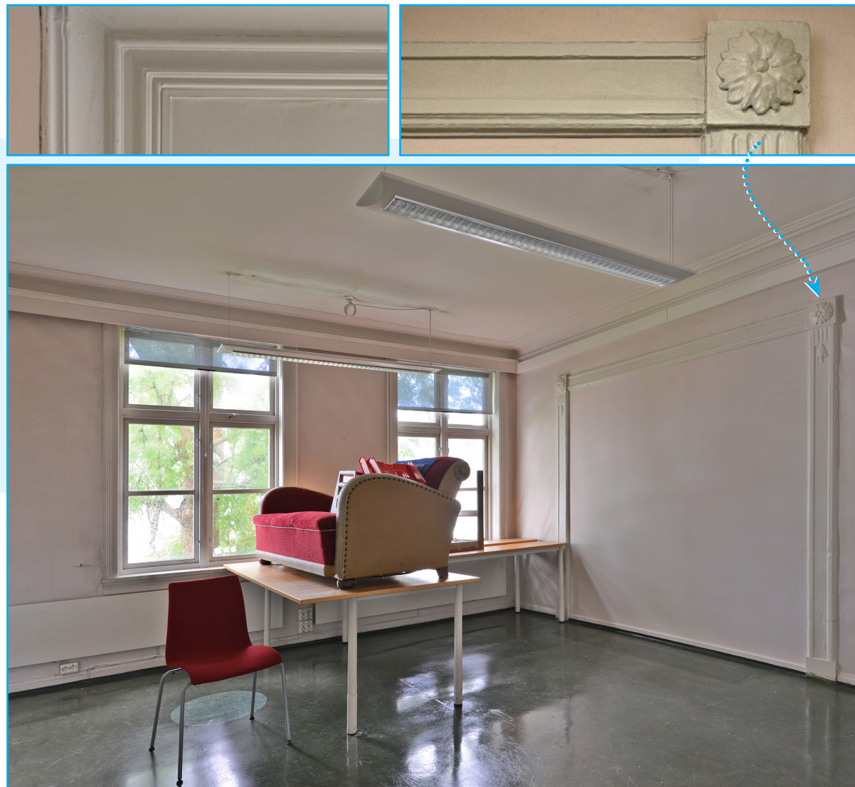
Dette har trolig vært stuen i nordfløyen. Rommet har blendet, dekorert åpning mot rom 115. Foto: EIA
