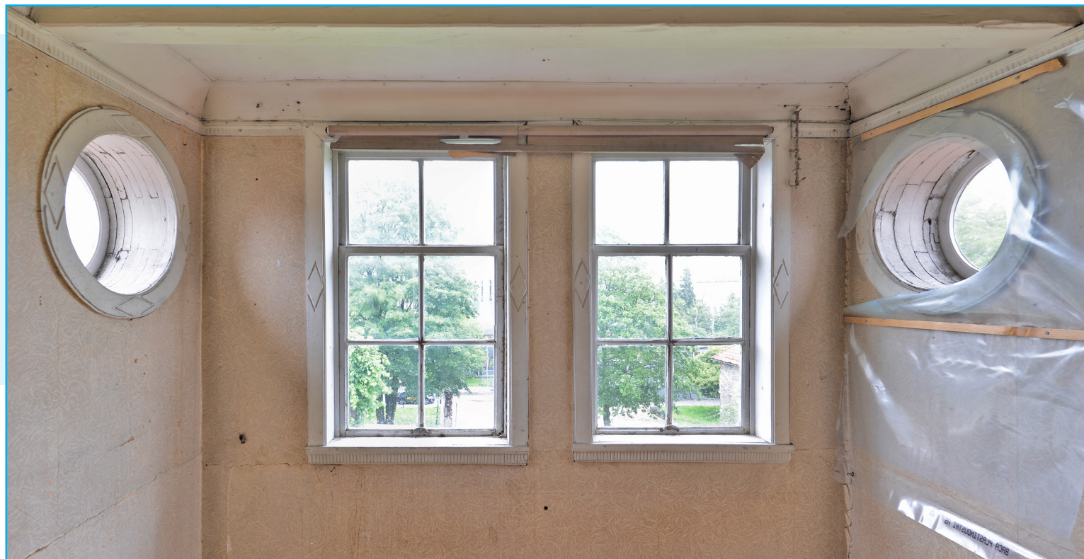
Dette største rommet i arkøyhusets 3. etasje med vindu mot øst, er et dekorert rom med mange originale bygningsdeler. Tapetet er gammelt, men har ukjent datering. Foto: EIA
