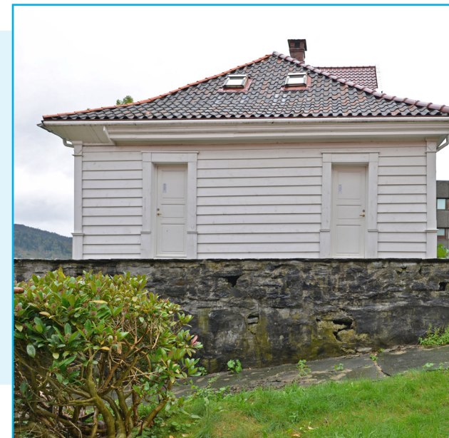
Fasade mot sør. Foto: EIA
