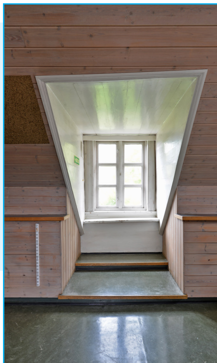
Vindusmyg mot øst har original panel på vegg.
