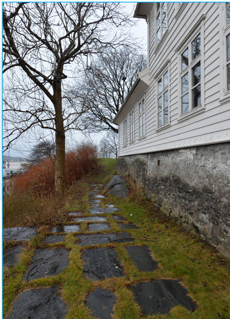
Hellelagt gangvei langs kjellermuren i vest. Foto: EIA
