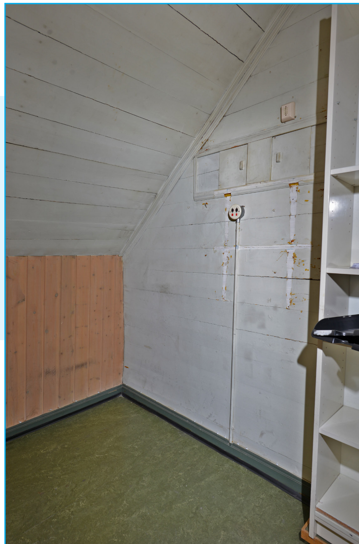
Arkivrommet har overmalt kledning som trolig er original. Foto: EIA
