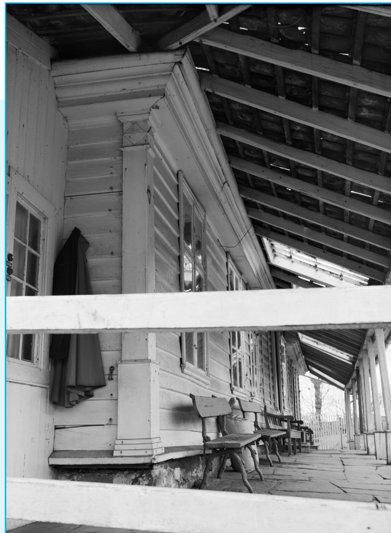
Bilde fra før 1965 som viser svalgangen foran østfasaden. Gesims, kledning og hjørnepilastre antas å være originale fra 1830. Svalgangen med overlys og søyler i front ble fjernet under restaureringen i ca. 1965. Fotograf ukjent, Universitetsmuseet i Bergen
