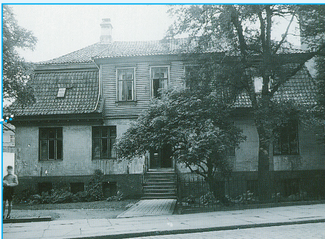
Våningshuset på Frøysethmarken ble revet i 1949. Foto: Olav Espevoll, Bergens museum
