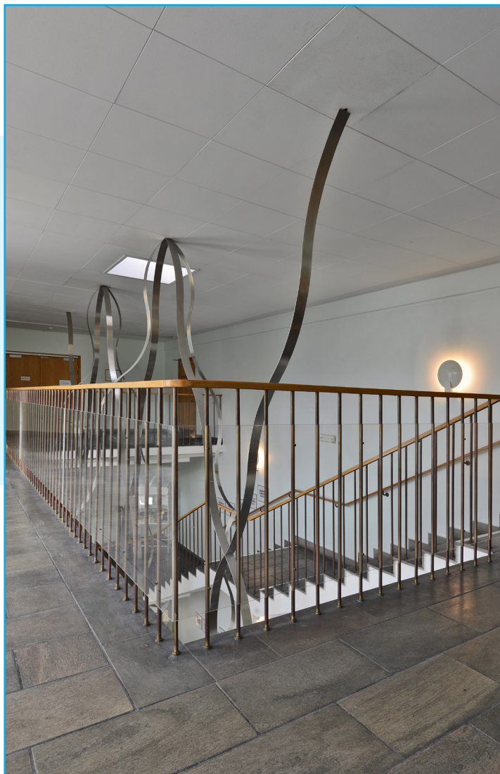
Nyere akustisk himling over trapperommet. Foto: EIA
