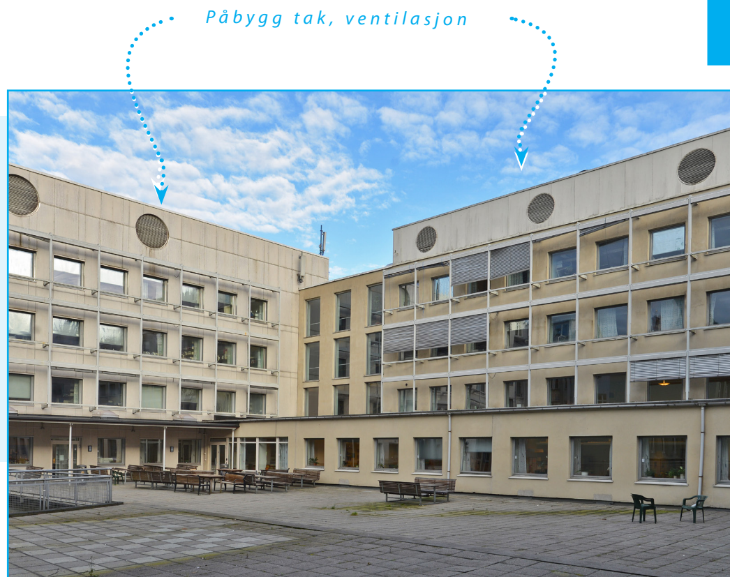
Fasade sør og vest vender mot et uteareal som er belagt med betongstein. Foto: EIA
