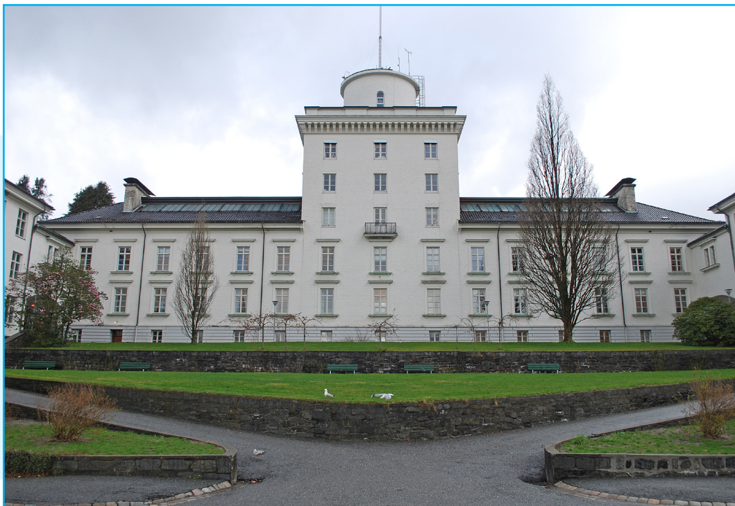
Arkitekt Egill Reimers tegnet hageanlegget mellom de to fløyene. Foto: EIA
