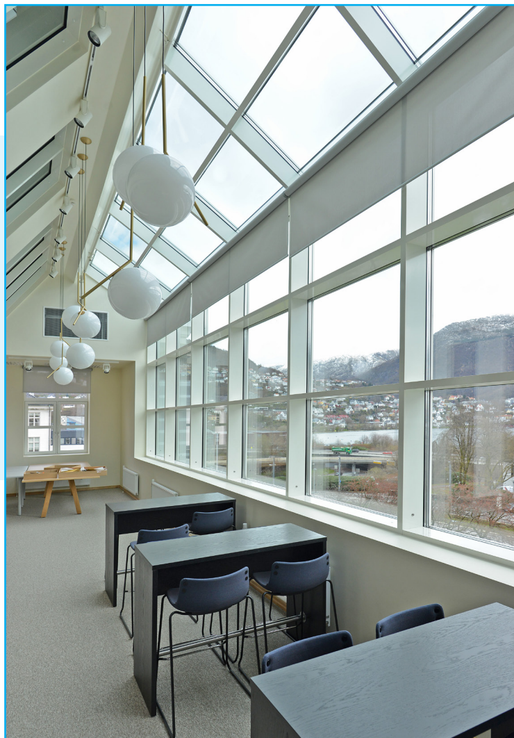
Det opprinnelige laboratoriet er blitt møte- og vrimlerom. Opprinnelig glassfasade/glasstak er tilbakeført. Foto: EIA
