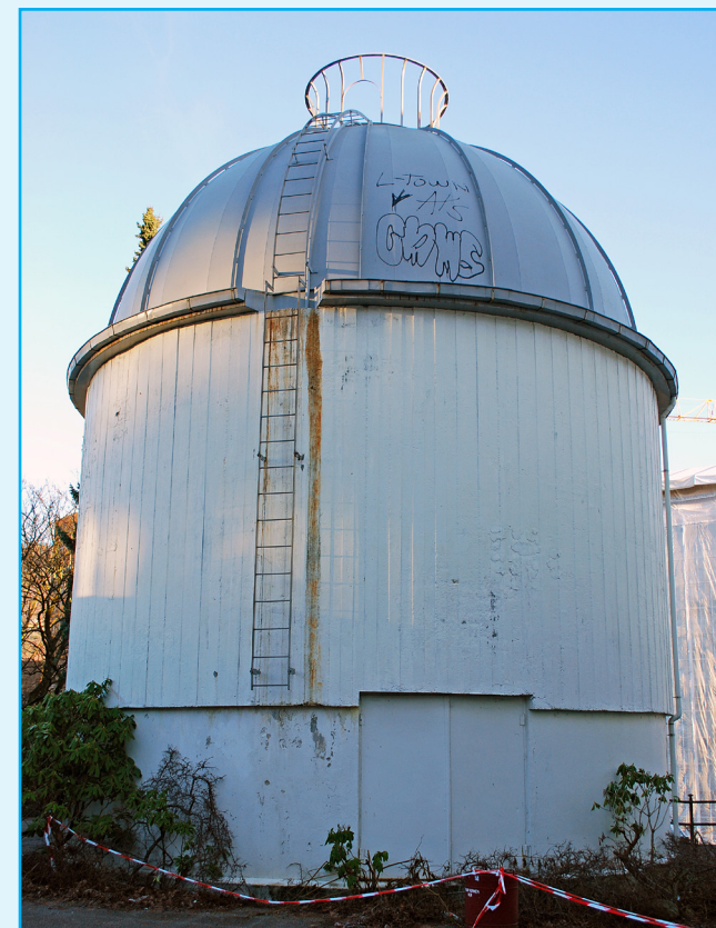
Stålkuppelen ble delvis kledt med betong i 1968. Foto: EIA
