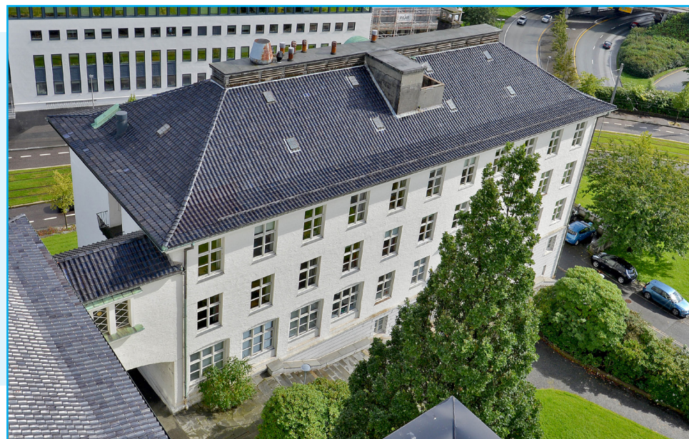
Yttertak Jahnebakken 3. Foto: EIA
