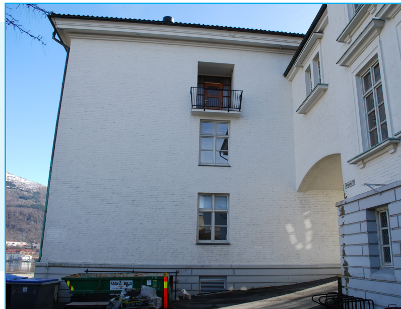
Fasade Jahnebakken 3 mot nord. Foto: EIA
