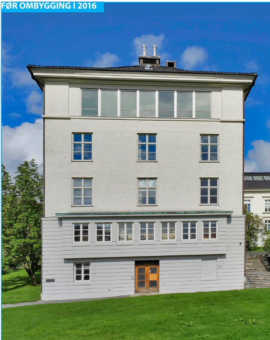
Jahnebakken 5, fasade mot sør før ombygging i 2016. Foto: EIA
