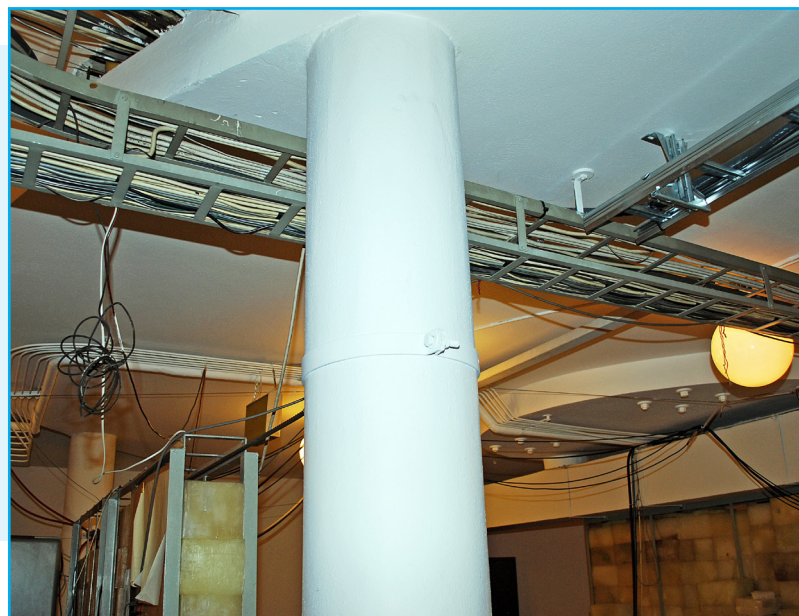
Ekstra søyle som støtter taket over laboratoriet. Foto: EIA
