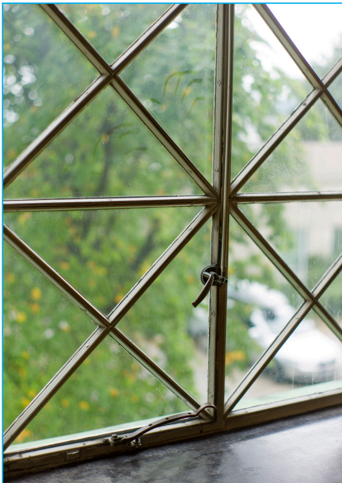
Detalj vindu i trappehall 2. etasje. Foto: EIA
