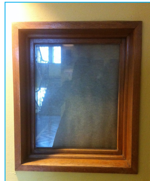
Luke i vegg i vestibyle. Foto: EIA
