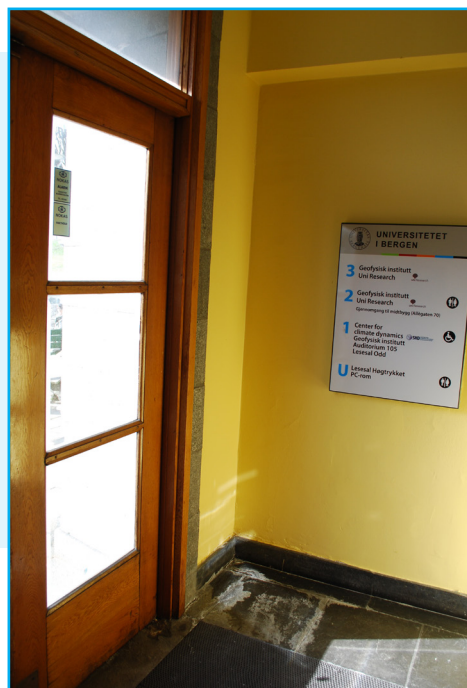
Vindfang ytterdør. Foto: EIA
