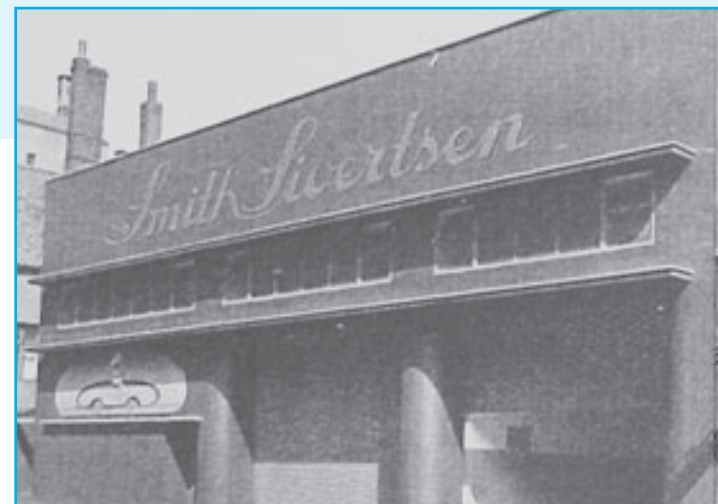
Nybygg i 1930 for Smith Sivertsens bakeri i Håkonsgaten 47 A. Regnet som Bergens første funksjonalistiske bygning. Fotograf ukjent. Hentet fra Arkitekturvandring i Bergen.
