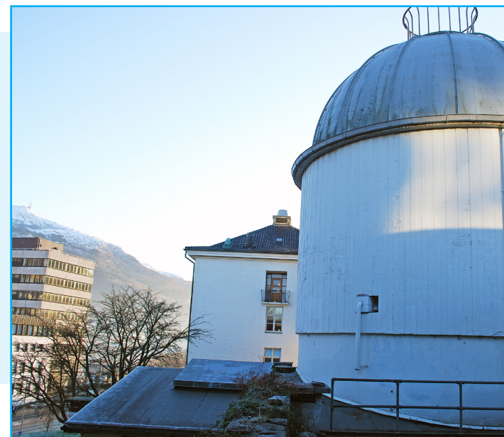
Fasade mot nord. Foto: EIA
