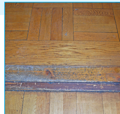
Originale dører, taklist og opprinnelig dørterskel. Foto: EIA
