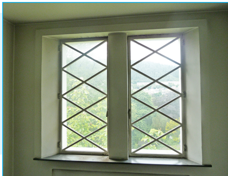
Tvillinghusene har samme type jernvinduer i trapperommet. Foto: EIA
