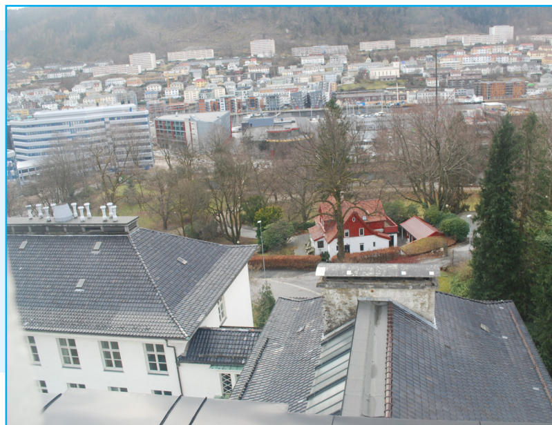
Geofysisk institutt, Allégaten 70. Tak sett fra tårnet mot vest. Foto: EIA
