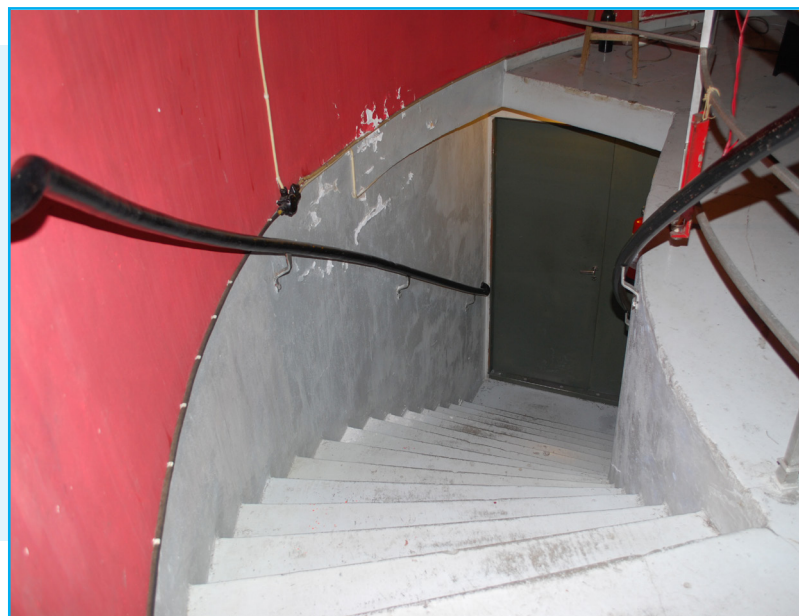
Trapp ned fra generatorrom til laboratorium. Foto: EIA
