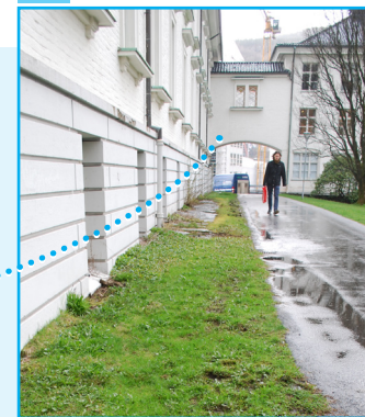
Gangbro mellom Geofysen og Jahnebakken 5. Foto: EIA
