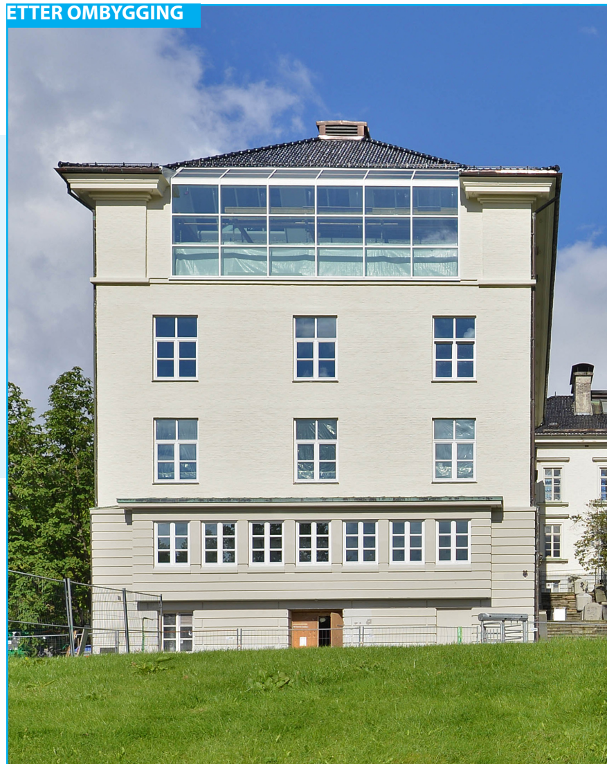
Jahnebakken 5, fasade mot sør etter ombygging i 2016. Foto: EIA
