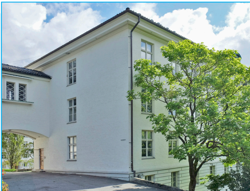
Fasade Jahnebakken 5 mot nord. Foto: EIA
