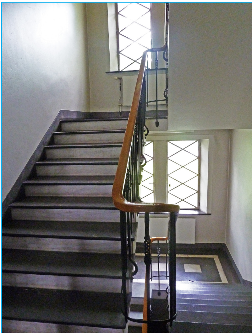
Trapperom i Jahnebakken 5 før renovering. Materialbruken er den samme som i Jahnebakken 3. Foto: EIA
