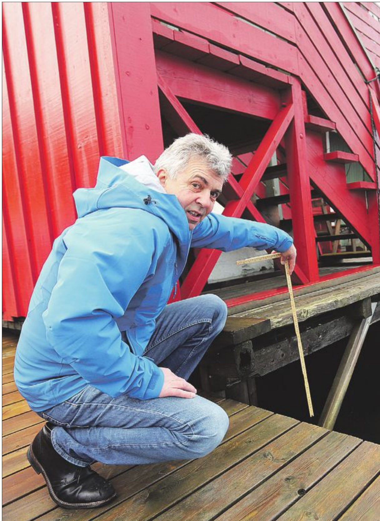
OPP HIT: Erik Birkeland sjekker med tommestokken hvor høy vannstanden vil være i 2090. – Den vil trolig stå 15 centimeter opp etter veggen.
