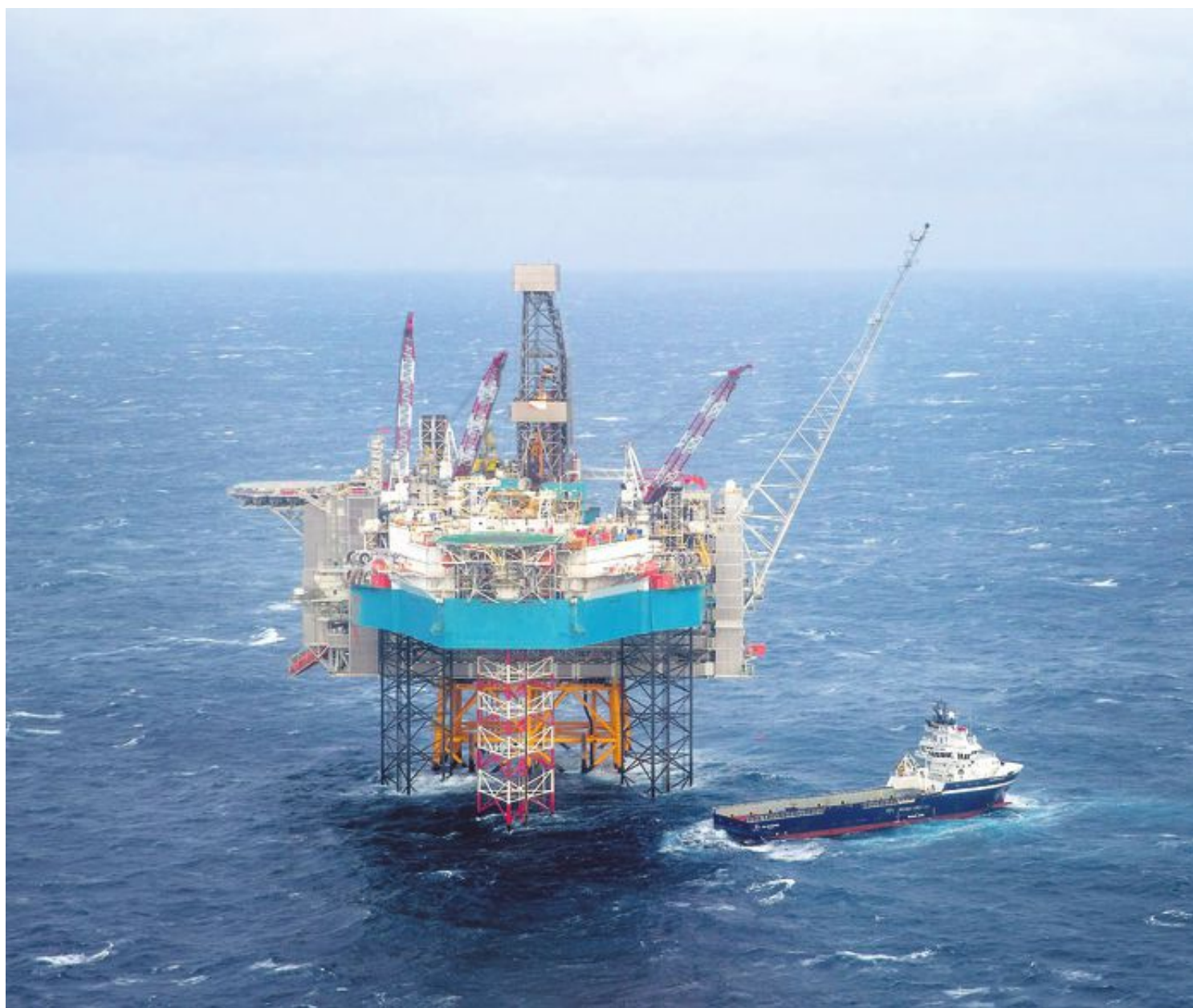
OLJE-LANDET: Selv om Norge i stor grad klarer seg med vannkraft, pumpes det store mengder olje og gass fra norsk sokkel. Er dette fremdeles nødvendig? spør Silje Skjelsvik i dette innlegget. Her er Edvard Grieg-feltet som ligger på Utsirahøyden i Nordsjøen, 180 km vest for Stavanger.
