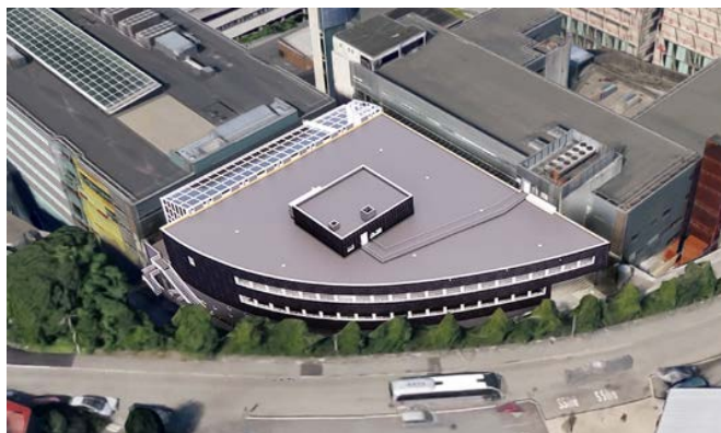
Bilde 2. Inkubatorbygget ved Haukeland universitetssykehus
