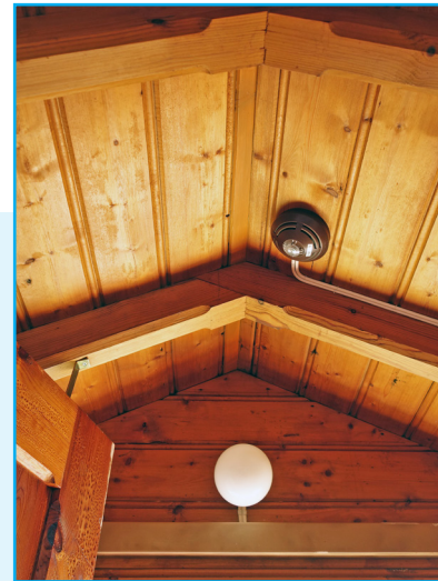
Tak i vindfang mot kjøkken. Foto: EIA
