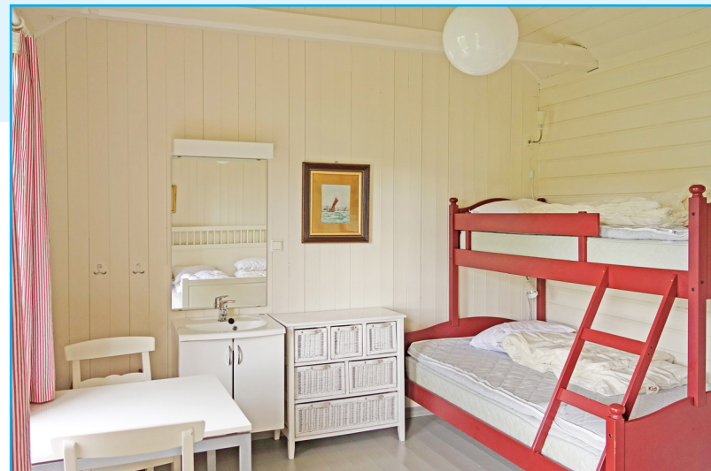
Rommet har stående panel mot våtrom. Foto: EIA
