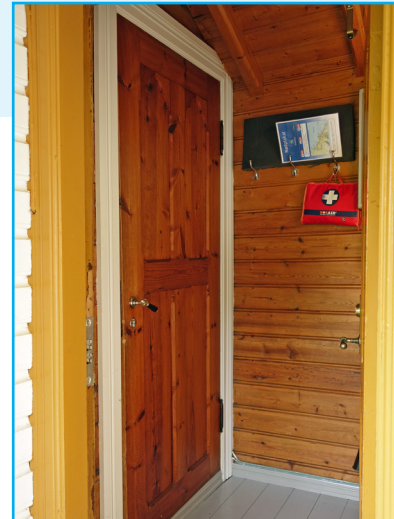
Original fyllingsdør inn til kjøkken.
