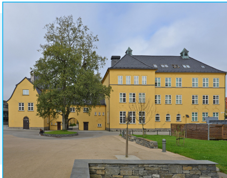
Fasade mot sør. Foto: EIA
