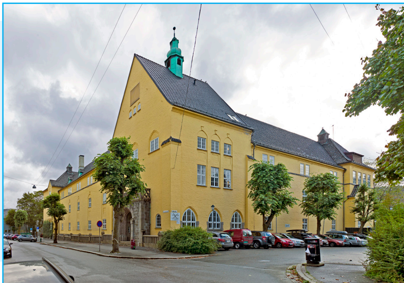
Fasade mot nord. Foto: EIA
