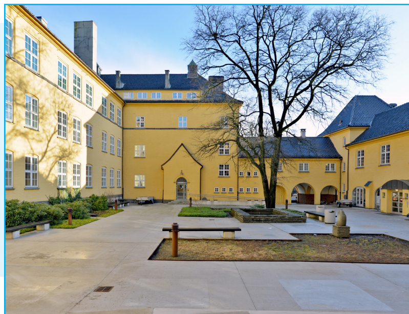
Fasade mot sør. Foto: EIA
