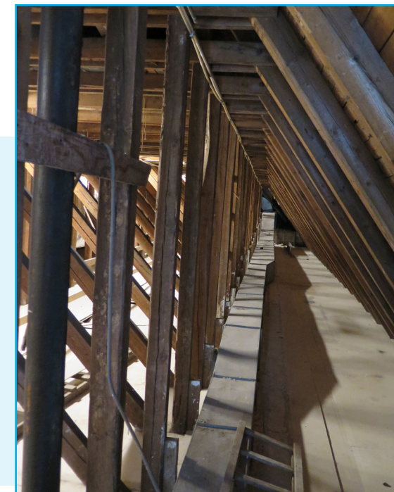
Takkonstruksjon fra innsiden. Foto: b+b arkitekter
