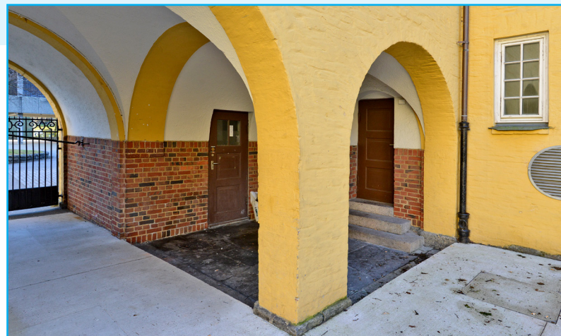
Porten med buehvelv mot sør er den mest brukte. Biinngangsdørene er originale.
