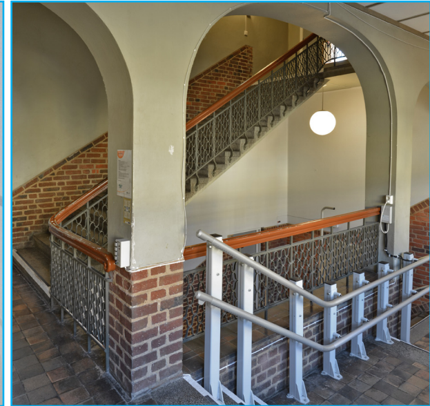
Trappeheis i hovedtrapp i vestfløy. Foto: EIA
