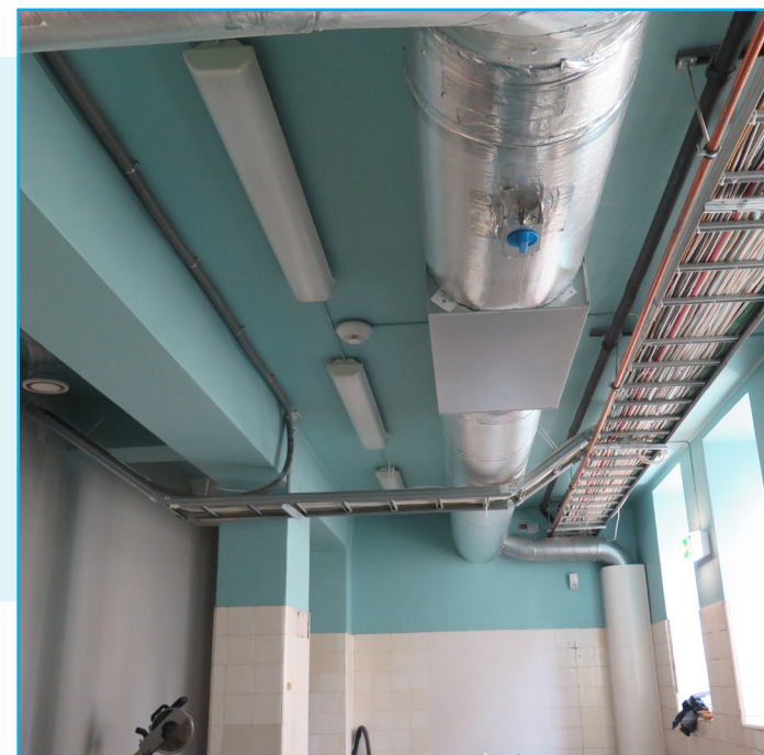
Malt betong i tak. Foto: b+b arkitekter
