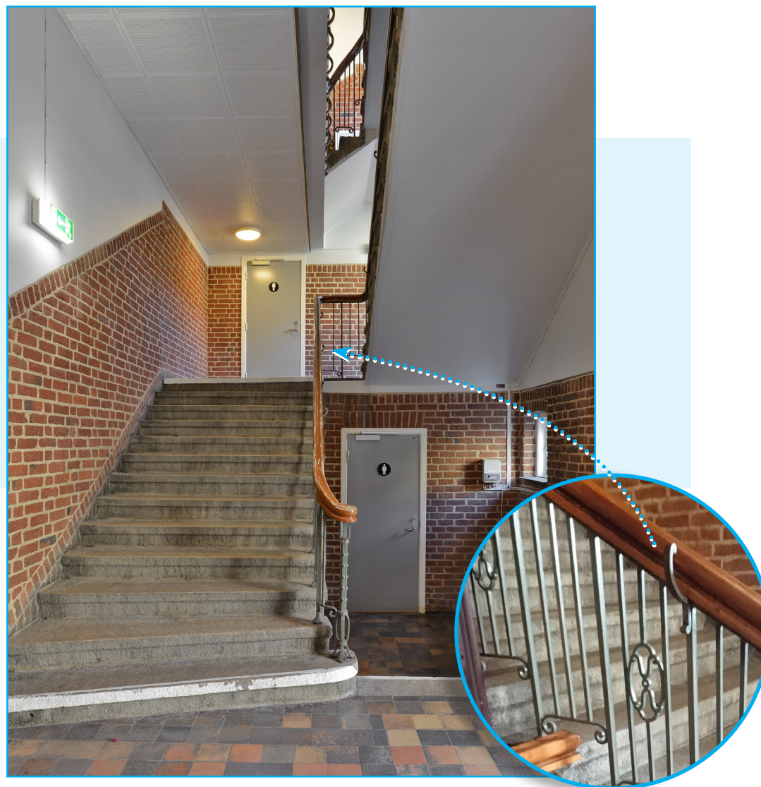
Trapp i skolens sørfløy. Rekkverket har knagger for våte klær og paraplyer. Foto: EIA
