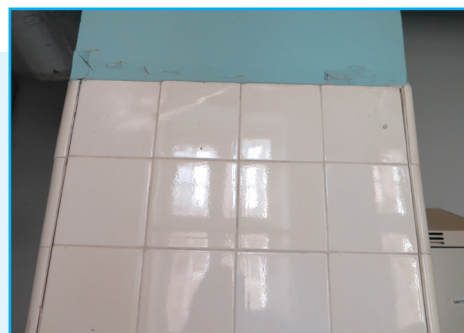
Veggene har antatt originale fliser. Foto: b+b
