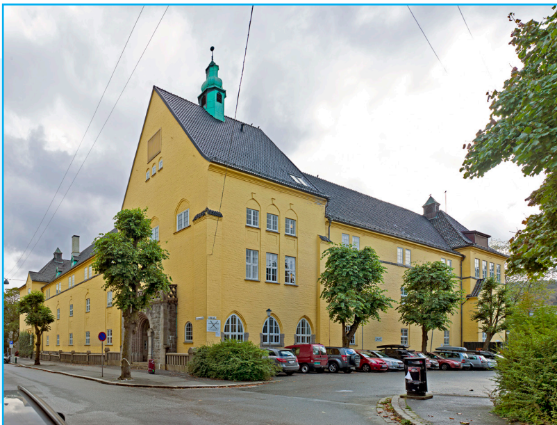
Fasade mot nordøst. Foto: EIA
