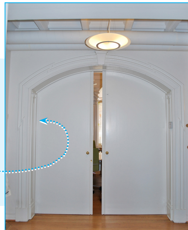
Skyvedør i rom 104, til rom 107. Foto: EIA
