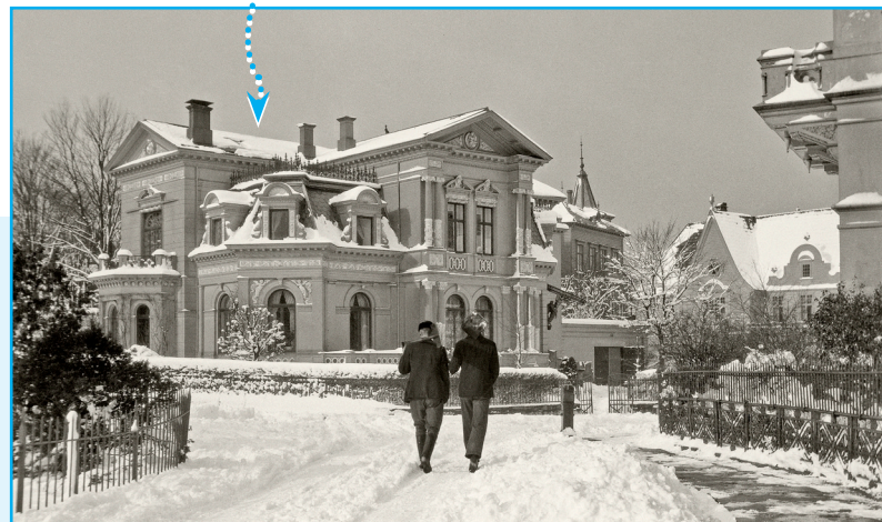
Parkveien. Foto: Olai Schumann Olsen, mellom 1920 og 1939, Universitetsbiblioteket i Bergen
