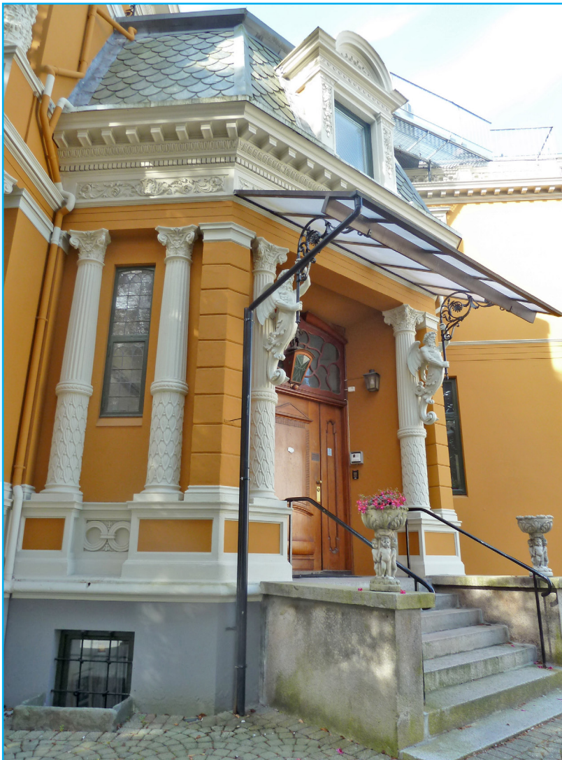
Inngangsparti, fasade øst. Foto: EIA
