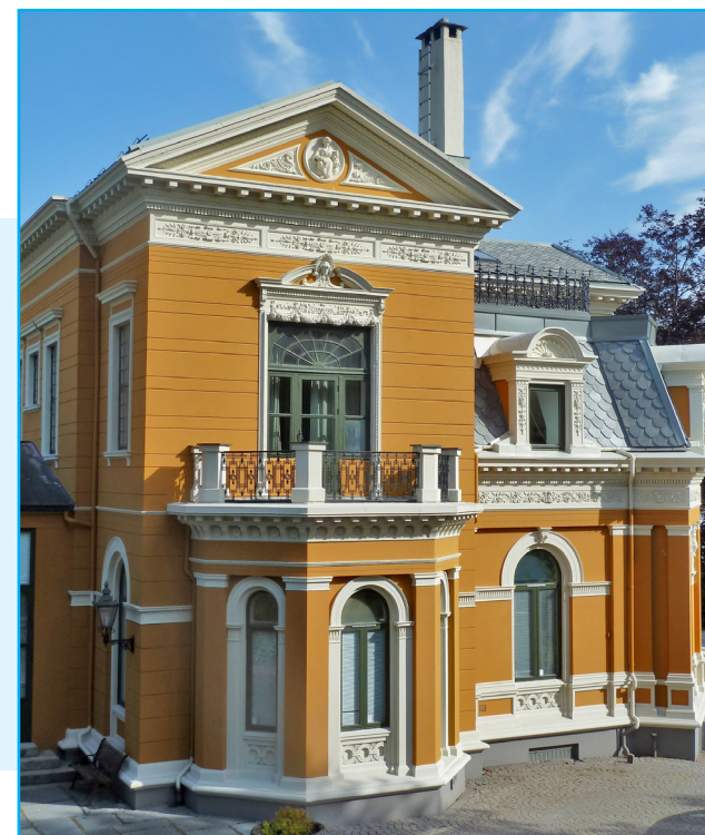
Fasade mot sør. Foto: EIA
