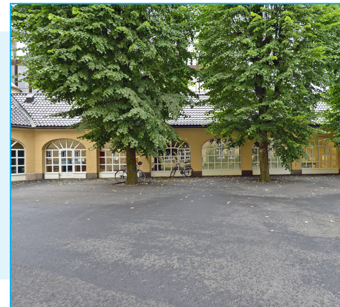
Uværsskurene, som opprinnelig var åpne, er kledd inn med vinduer i de store åpningene. Foto: EIA
