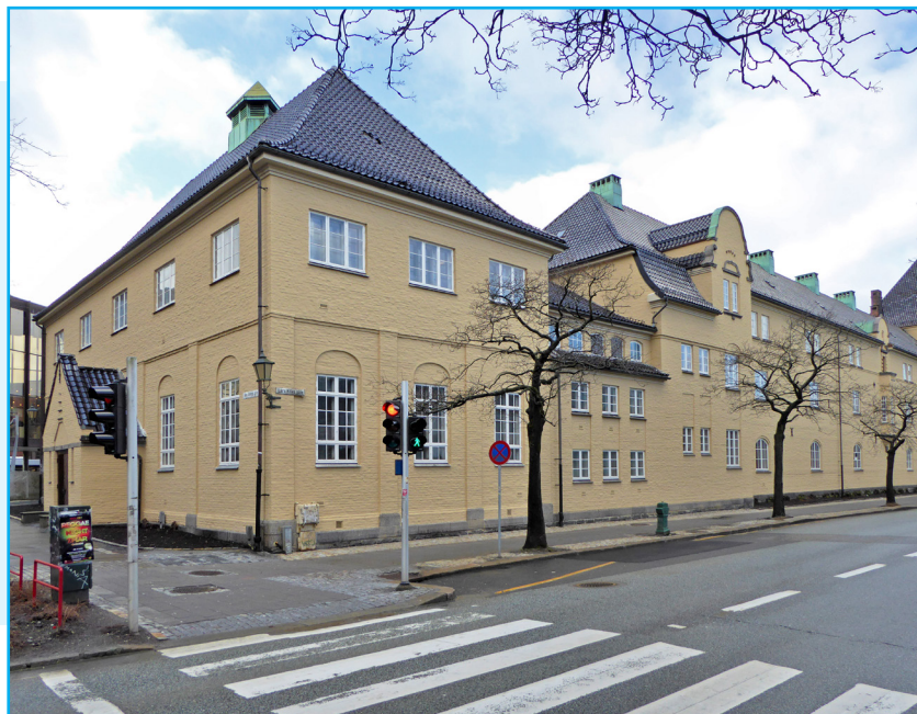
Fasade mot Lars Hilles Gate. Foto: EIA
