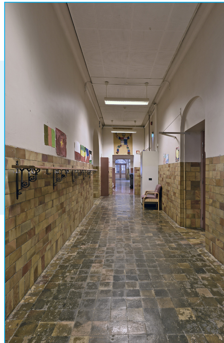
Korridor 1. etasje. Foto: EIA
