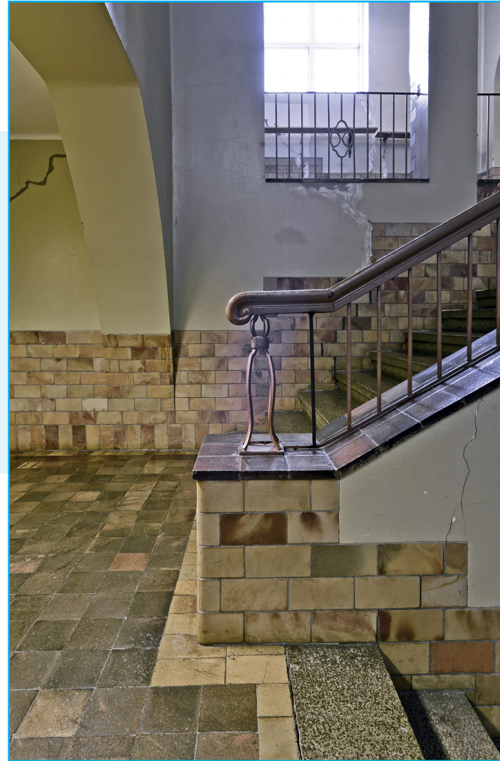
Repos i hovedtrapp mellom tredje og fjerde etasje. Foto: EIA
