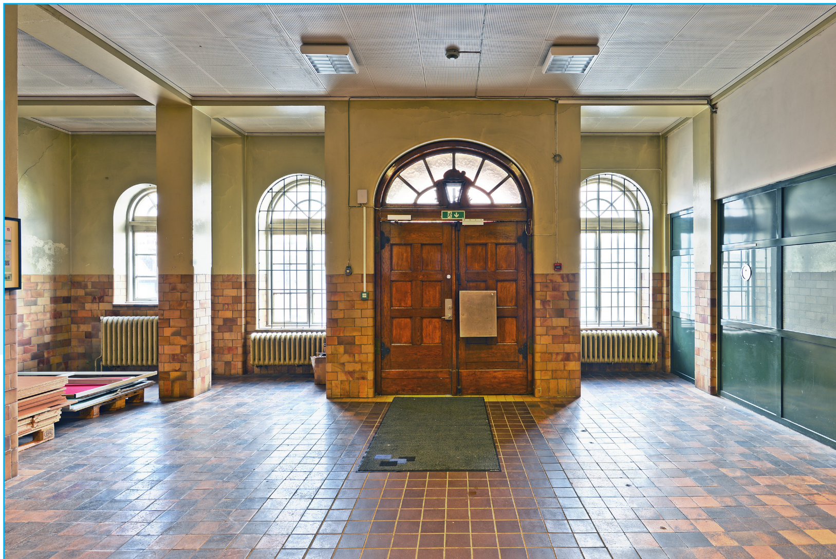
Skolen hovedtrapperom med original inngangsdør som vender ut mot Lars Hilles gate. Foto: EIA
