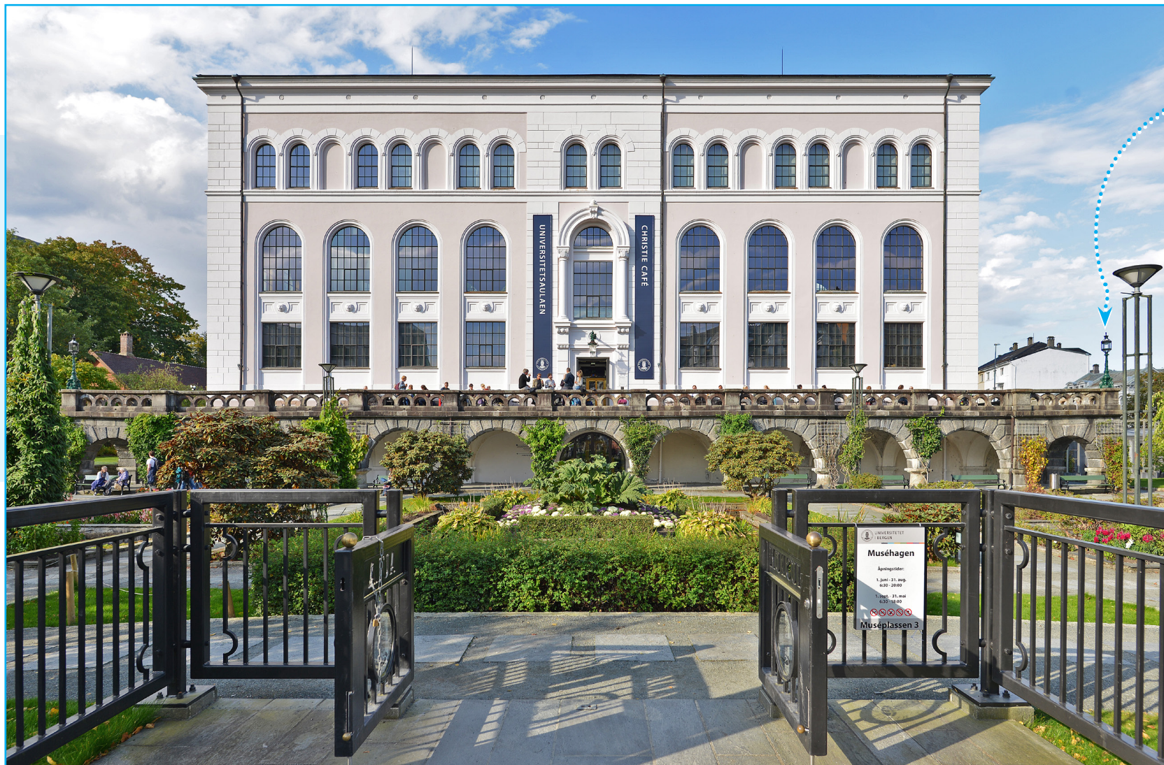
Ved renovering av muséets sørfly i 2016 fikk Muséhagen en ny inngang fra Olav Ryes vei til den stramt anlagte vannhagen. Foto: EIA
