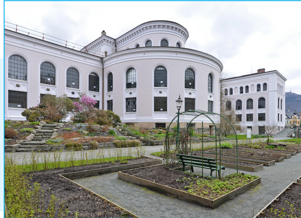
Fasade mot Puddefjorden. Foto: EIA
