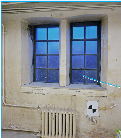
M-rom 033 Magasin, 2017. Gamle radiatorer
