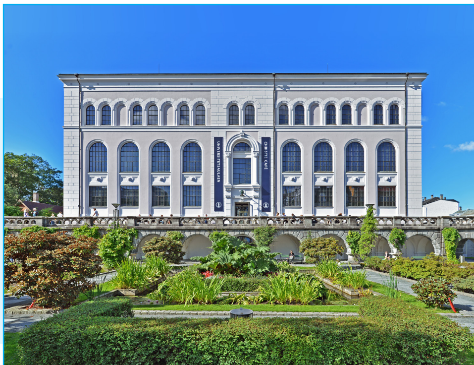
Fasade mot Parkveien. Foto: EIA
