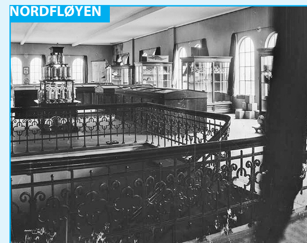
NORDFLØYEN Bilde fra den mineralogisk-geologiske samlingen i andre etasje i nordfløyen i 1908 med opprinnelig trapp før heis installeres. Foto: UBB
