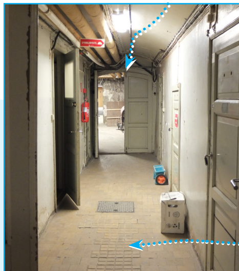
Midtbygg-rom 017 Korridor kjeller, 2012
