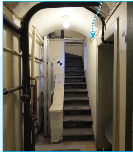
M-rom 031 Korridor til Vestibyle, 2012
