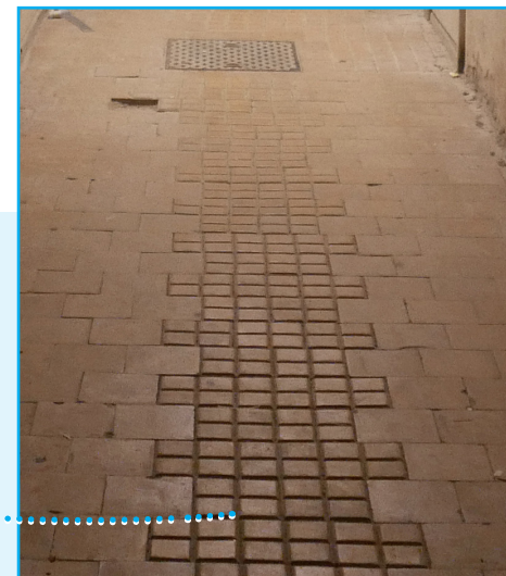
M-rom 017 Korridor kjeller, 2015. Originale fliser
