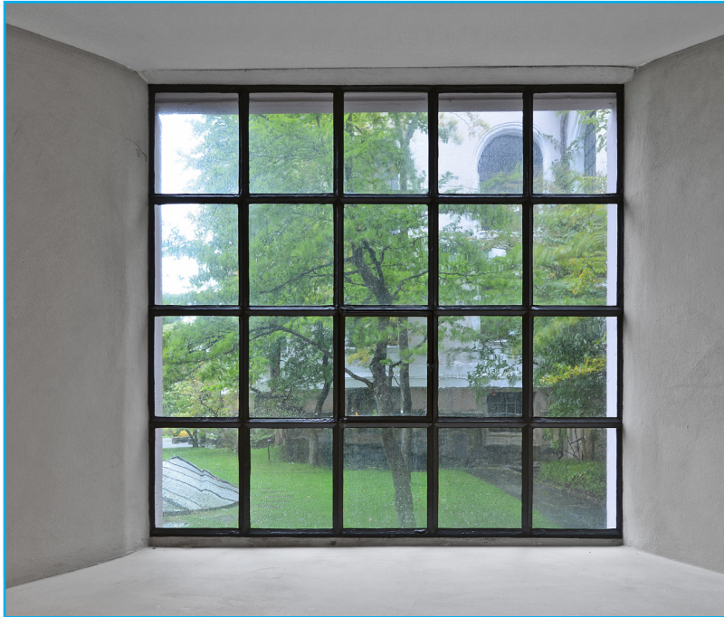
Nytt vindu i gammel døråpning i kjelleretasje. Foto: EIA
