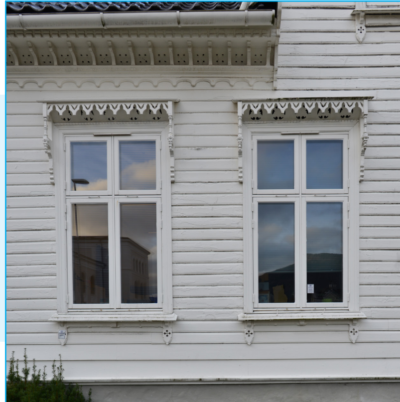
Langes gate 3. Fasadeutmykning i sveitserstil. Foto: EIA
