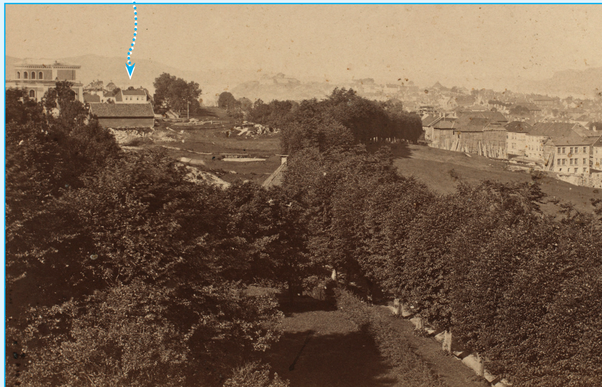
Her ser vi museet i venstre bildekant og arken i sørfasaden til Langes gate 3 bak en gammel løe. Dette bildet er tatt før 1876 da Christies gate 20 ble bygget som det første nye bolighuset øverst i Christies gate. Foto: Marcus Selmer, Universitetsbiblioteket i Bergen
