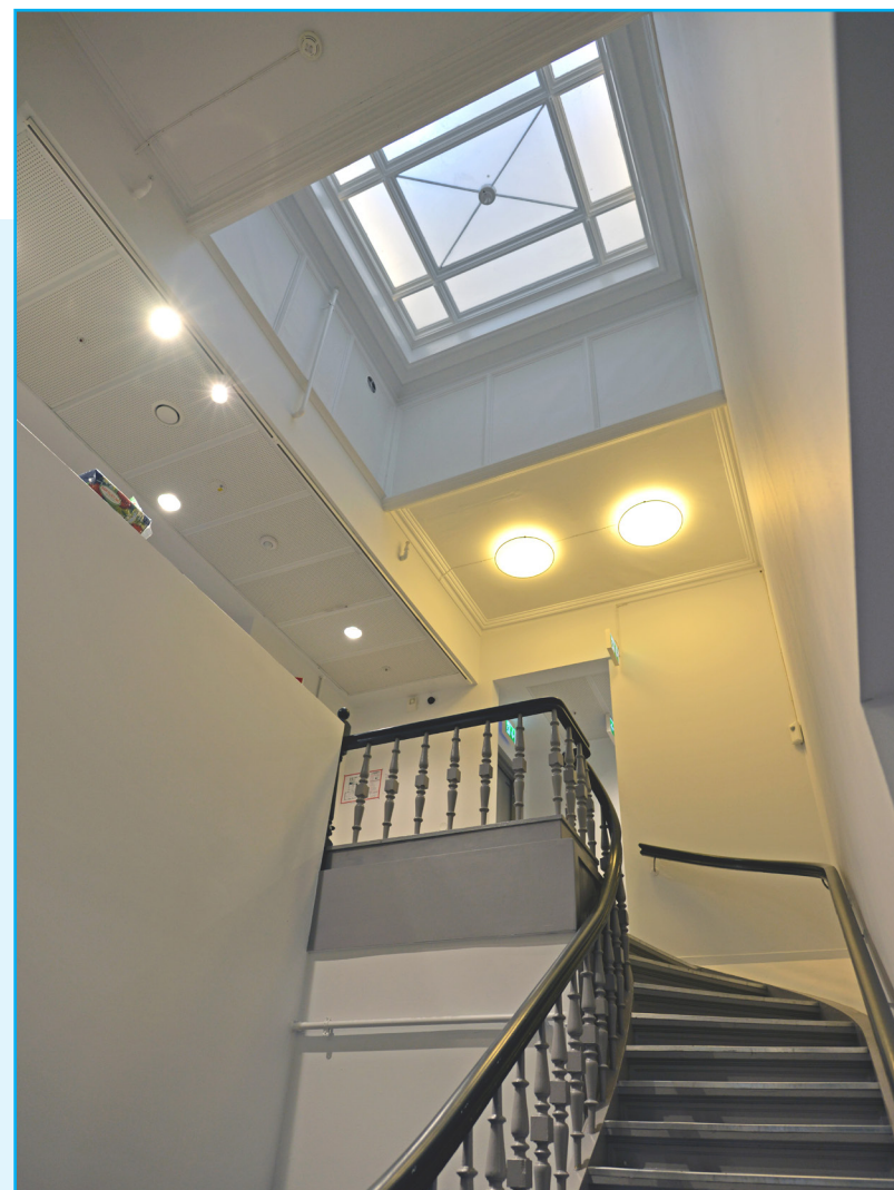
Langes gate 1. Original hovedtrapp med overlys. Foto: EIA
