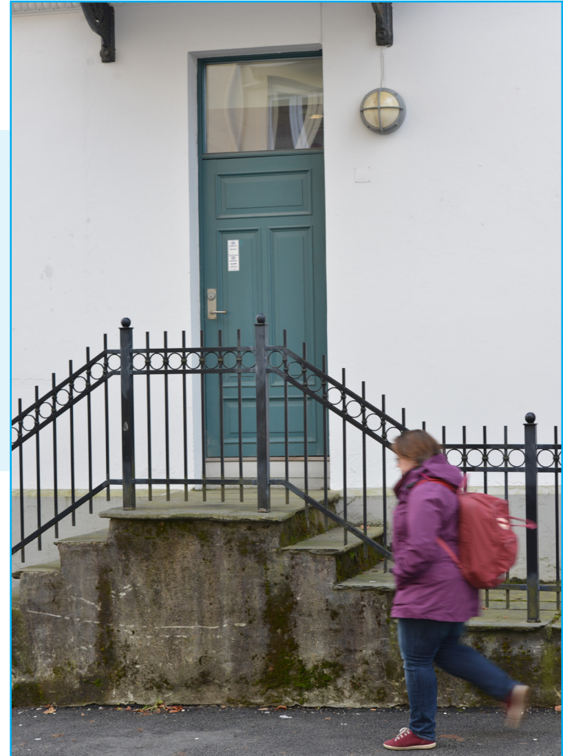
Bakdør i Langes gate 1 mot Langes gate. Nyere stålgerde i moderne utførelse. Foto: EIA
