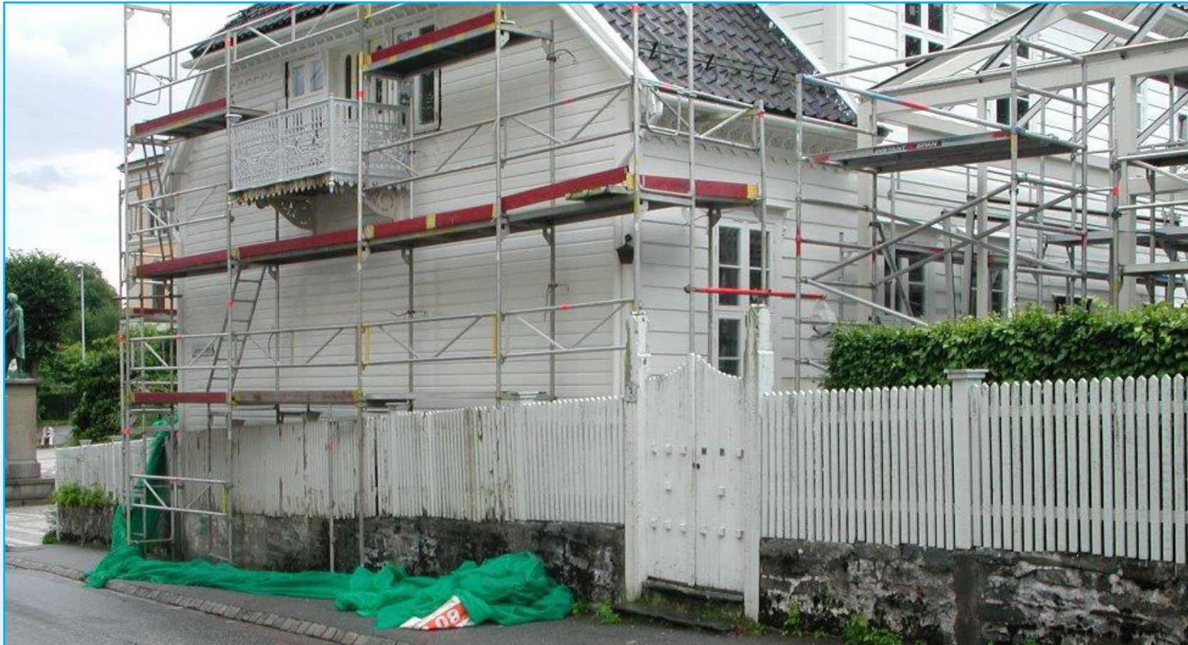
Langes gate 3 under rehabilitering i 2001. Da ble stakittgjerdet foran trevillaen og den tette treporten erstattet av et stålgjerde i ny utførelse. Foto: EIA
