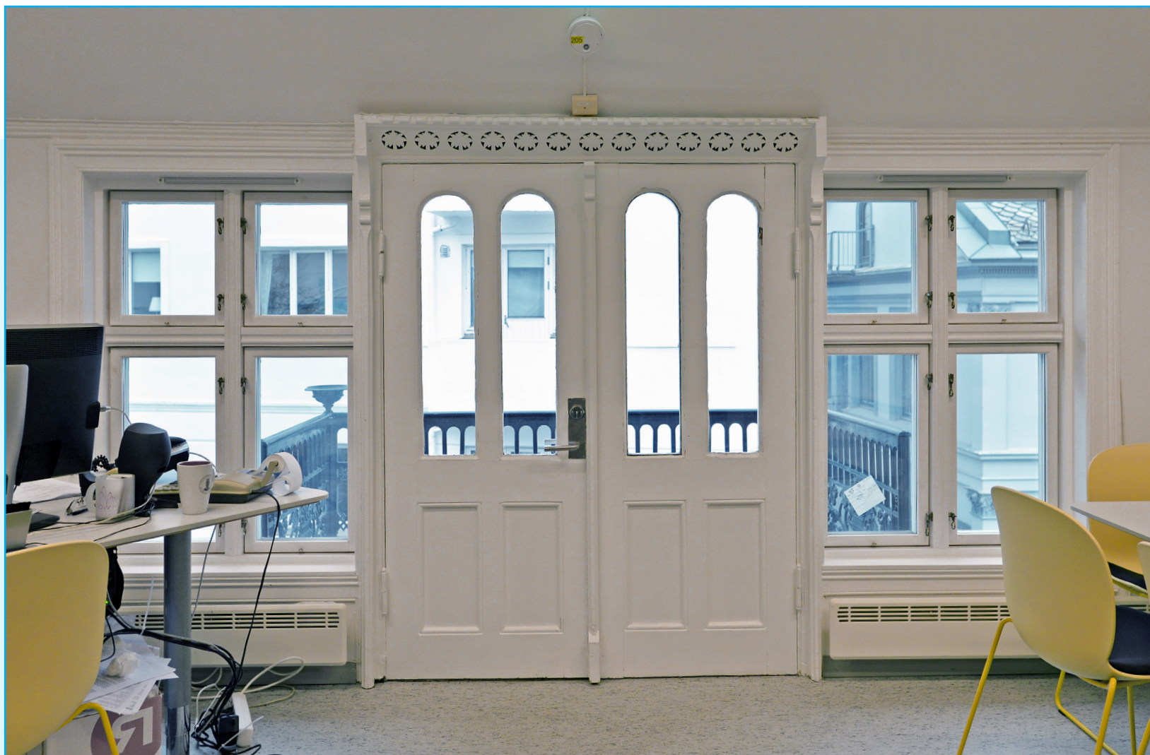
Langes gate 3. Utsmykket støpejernsbalkong, original balkongdør og sveitserdekorert listverk. Foto: EIA
