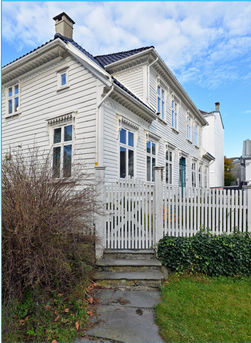
Langes gate 3. Husets opprinnelige hovedadkomst. Foto: EIA
