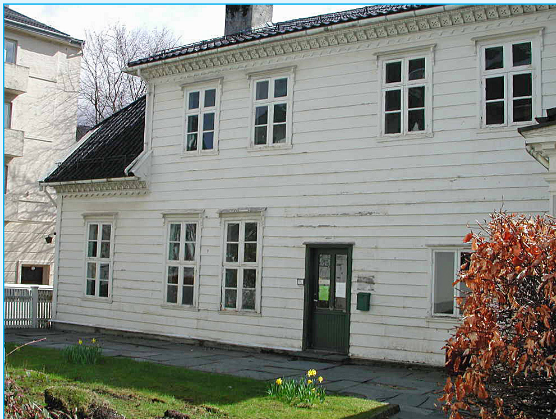
Langes gate 3 før restaurering i 2001. Foto: EIA
