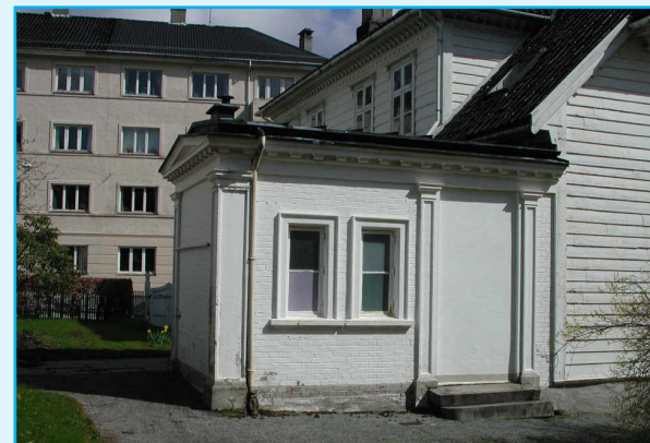
Trevillaens tilbygg i mur (Langes gate 3) ble revet i 2001. Foto: EIA
