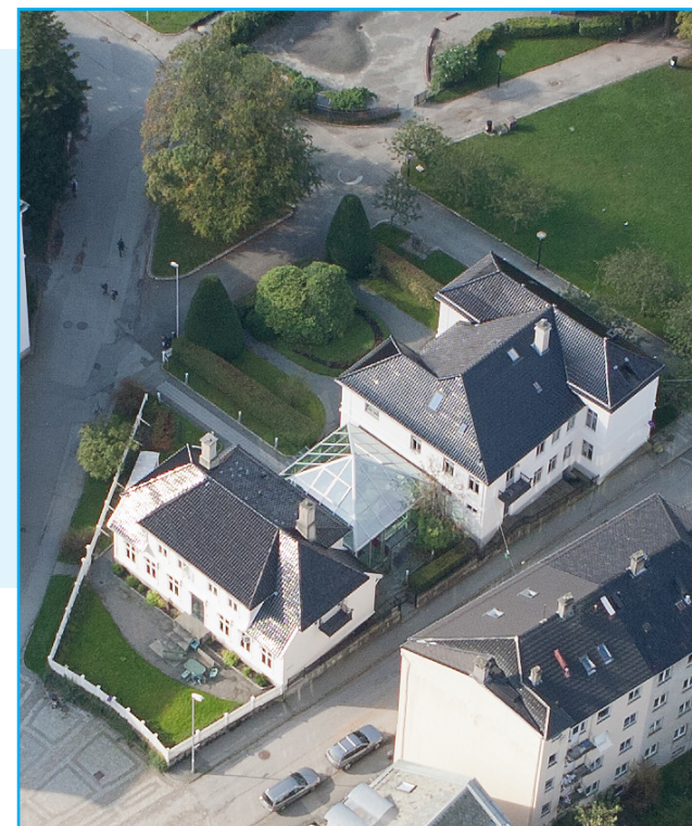
I 2001 ble de to husene i Langes gate knyttet sammen med en glasspaviljong. Foto: UiB, Alf Edgar Andresen
