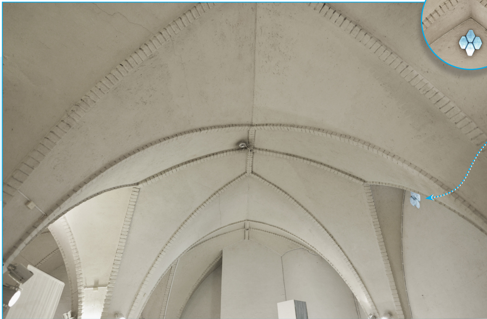
Takhvelv over utstillingsrom i tårnets 4. etasje. Foto: EIA
