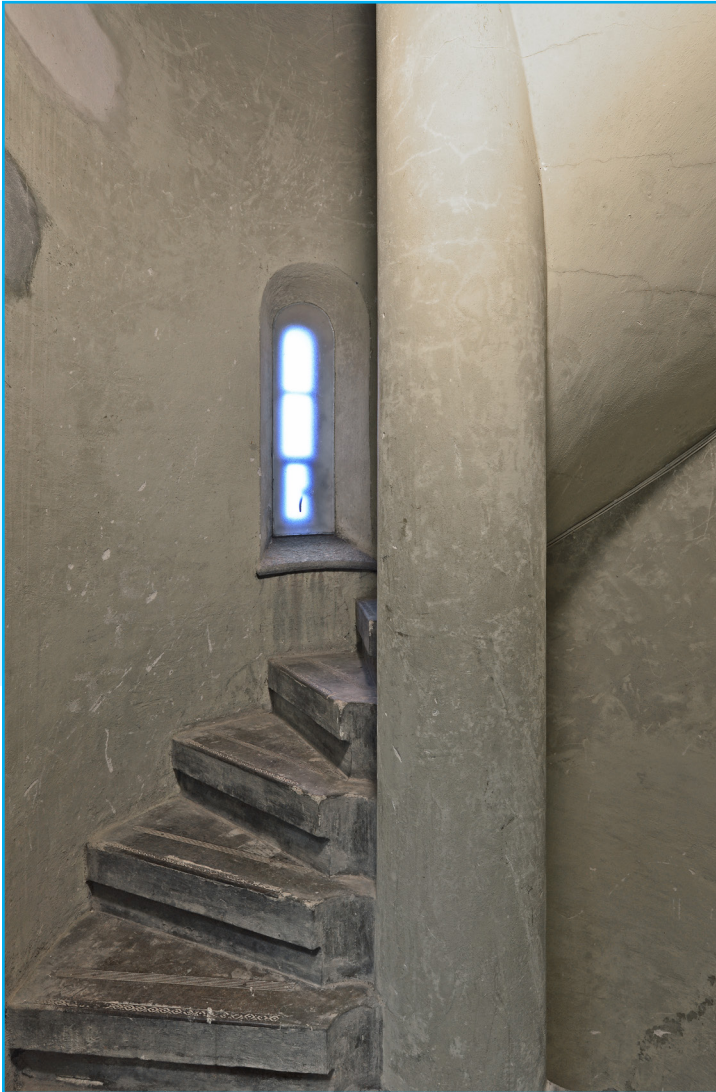
Tårnets spindeltrapp i betong har dekorerte trinn og vinduer formet som skyteskår. Foto: EIA
