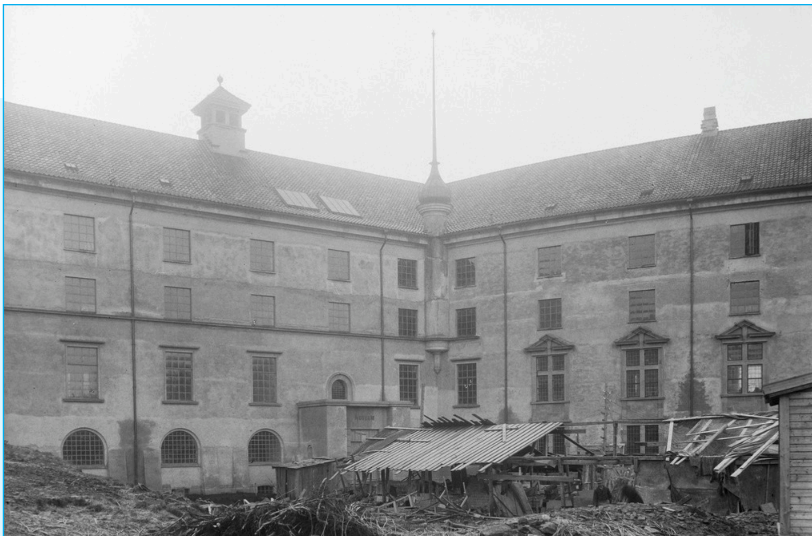
Nybygget er under oppføring. Foto: Atelier KK i februar 1925, Universitetsbiblioteket i Bergen
