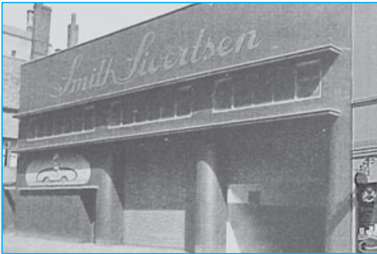
Nybygg for Smith Sivertsens bakeri i Håkonsgaten 47a, 1930. Regnet som Bergens første funksjonalistiske bygning. Fotograf ukjent. Hentet fra Arkitekturvandring i Bergen.
