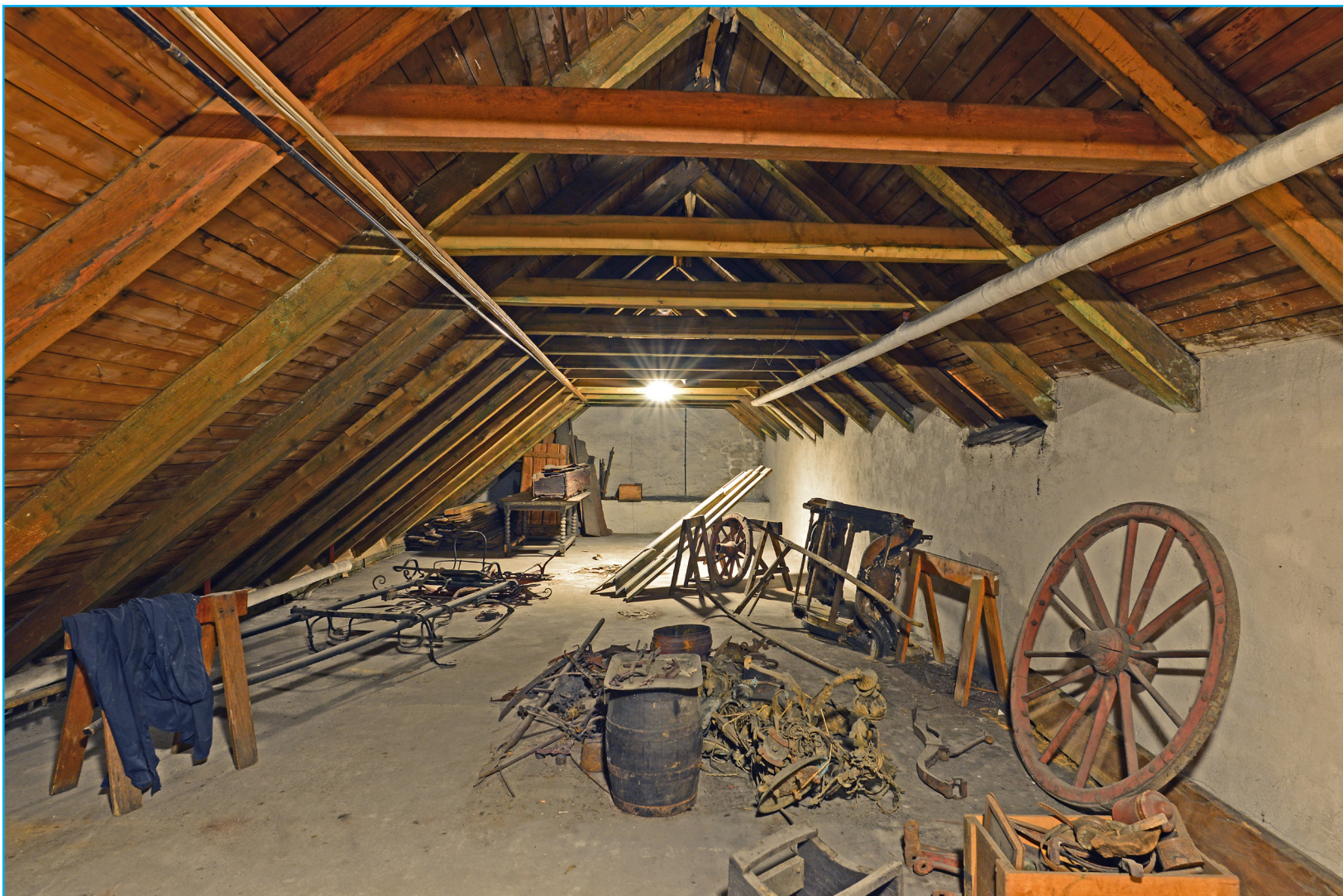
Loft, rom 501, med synlig takkonstruksjon. Foto: EIA
