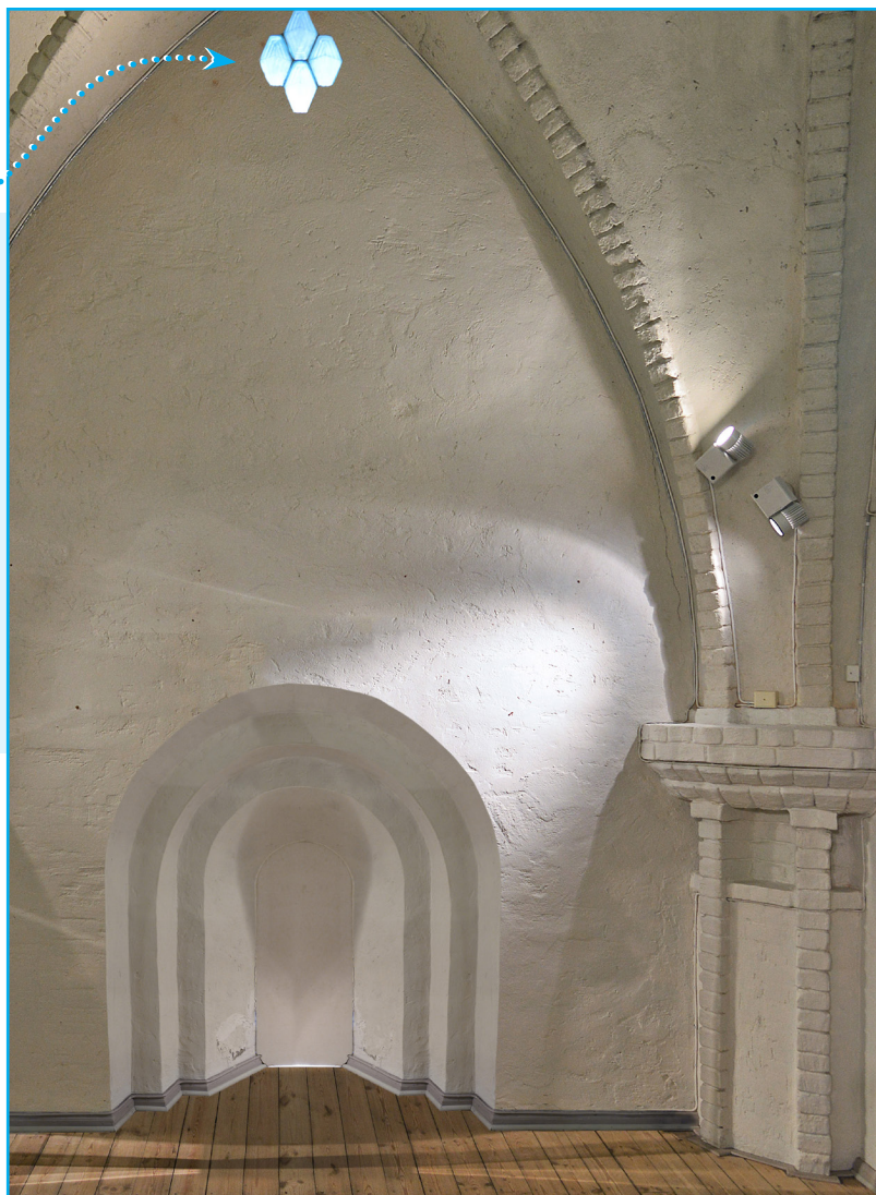
Nisje i vegg, utstillingsrom 4. etasje. Foto: EIA
