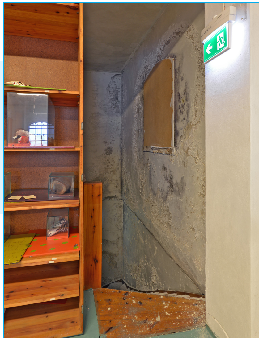
En smal trapp fører fra 7. etasje ned til 6. etasje. Foto: EIA
