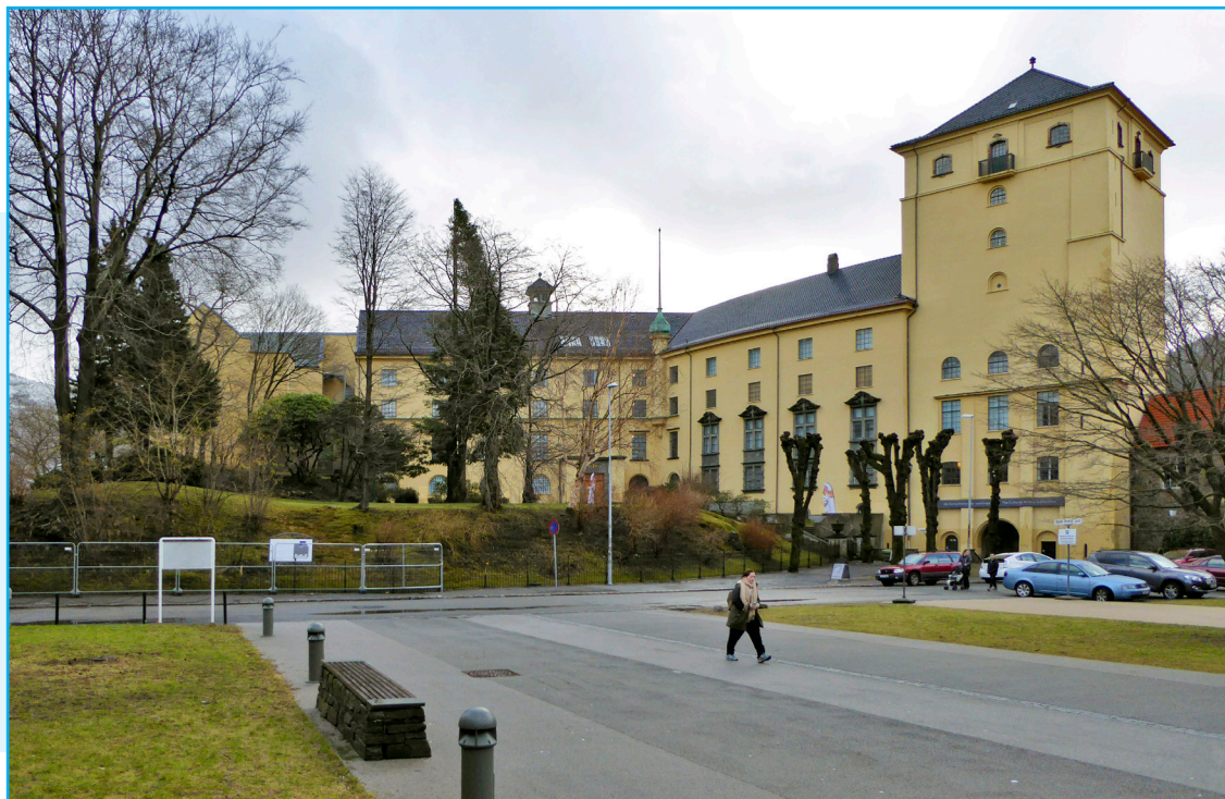
Historisk museum er en monumental markør ytterst på Sydneshaugen, ved inngangen til universitetsområdet på Fastings Minde fra vest. Foto: EIA
