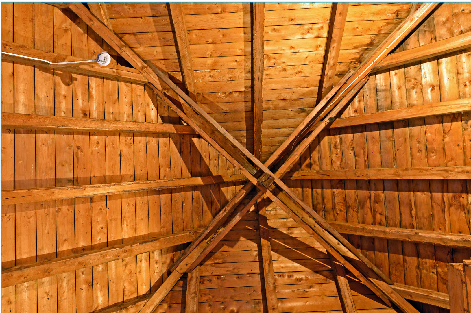
Rom 801. Tårnets tak holdes oppe av trekonstruksjoner. Foto: EIA
