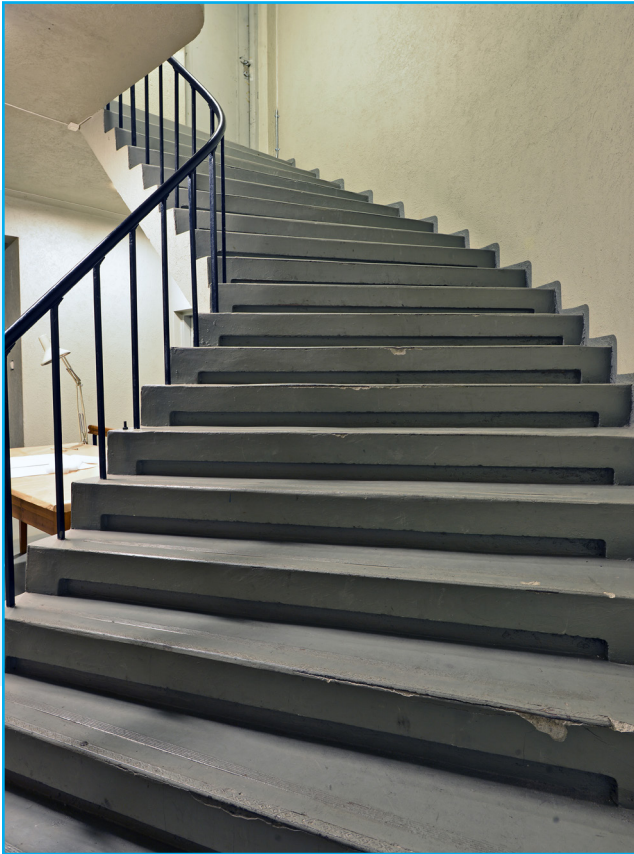
En betongtrapp fører fra 4. etasje til magasinrom i 5. etasje. Foto: EIA
