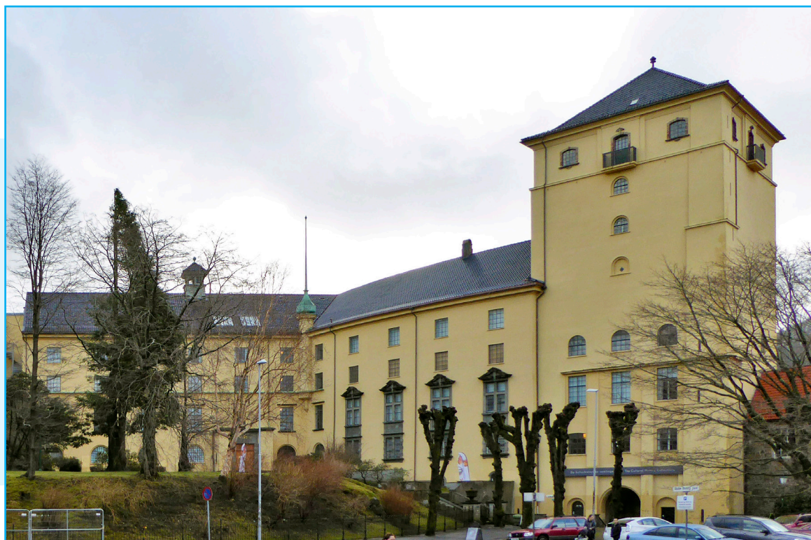
Fasade mot Haakon Shetelig's plass, nord. Foto: EIA
