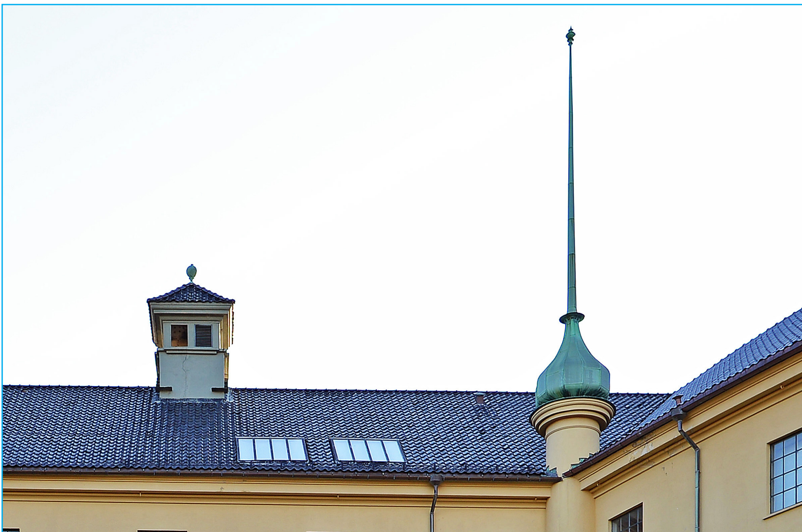
Arkitekt Egill Reimers overlot ingenting til tilfeldighetene. Denne bygningen er et gjennomarbeidet kunstverk, arkitekten har tegnet alle detaljer. Her på taket ser vi tårnet med spir som strekker seg høyt over hjørnet der de to fløyene er koblet sammen, samt kulen over ventilasjonshetten. Foto: EIA
