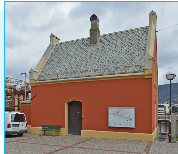
Fasade mot sør. Foto: EIA
