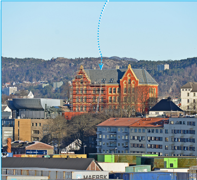
Dragefjellet skole, Jussbygget. Foto: EIA
