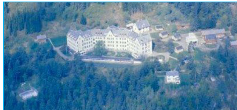
Luster Sanatorium på Harastølen i Luster, tegnet av Adolph Fischer, stod ferdig i 1902. Tuberkulosepsykiatrihuset ble psykiatrisk sykehus på 1950-tallet. Blant de første pasientene var de som ble overført fra Rosenbergs asyl på Sydneshaugen, da denne institusjonen ble nedlagt i 1959. Foto: Norvin Reklamefoto. Universitetsbiblioteket i Bergen
