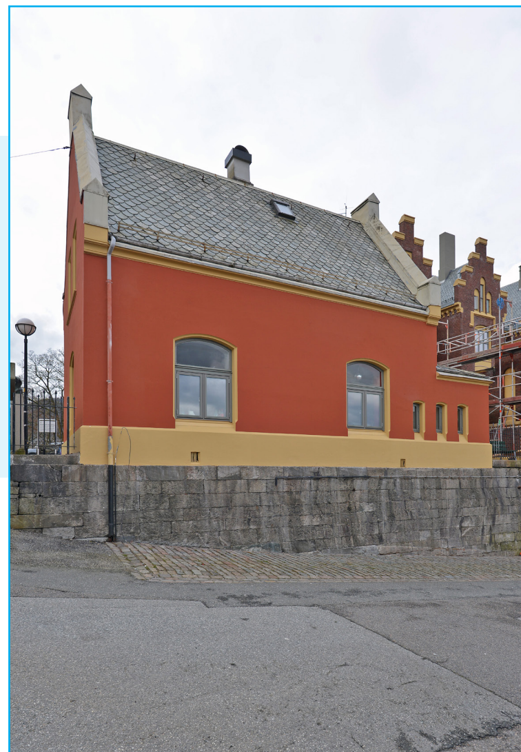
Fasade mot nord. Foto: EIA
