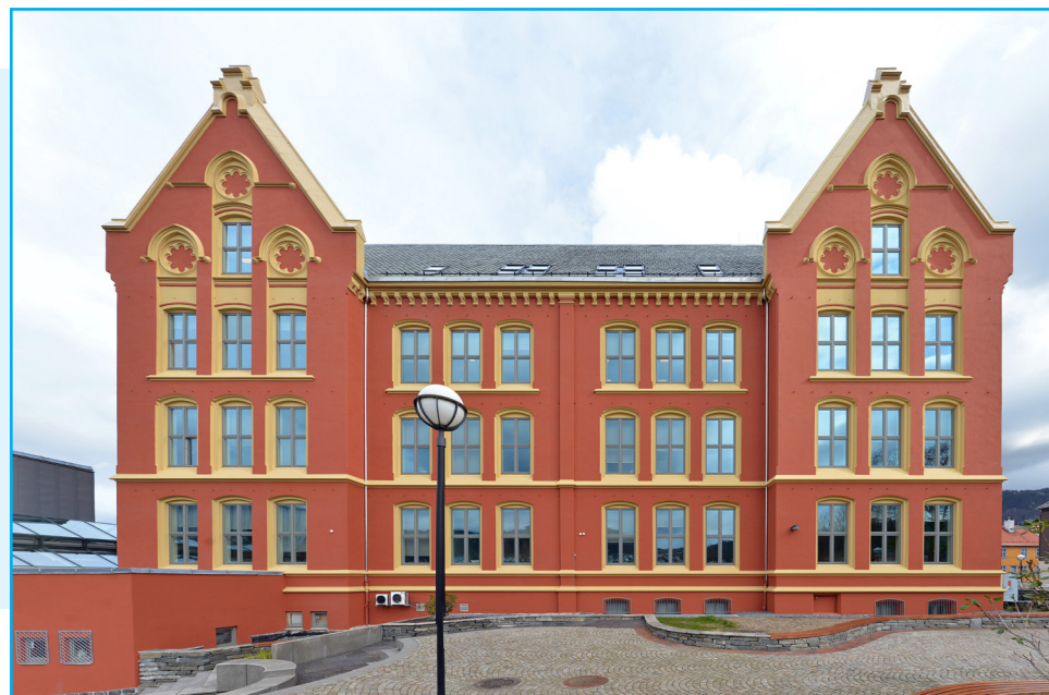
Fasade mot sør. Foto: EIA
