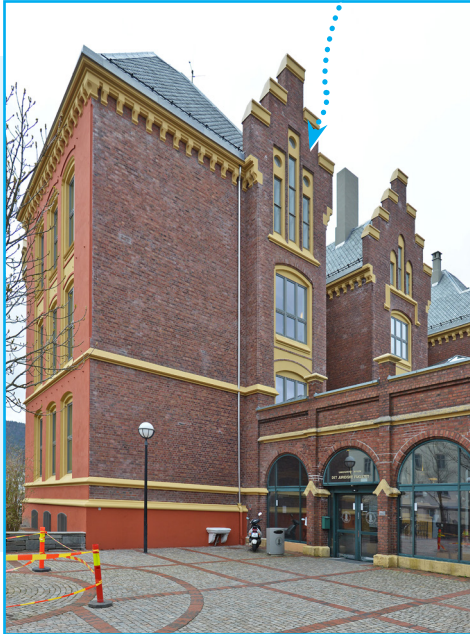
Fasade mot nord. Foto: EIA
