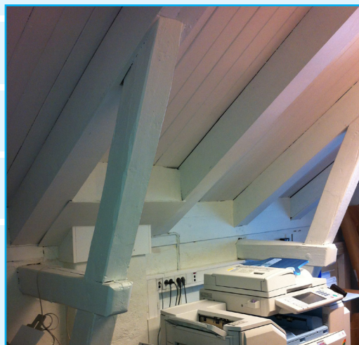
Originale takkonstruksjoner er bevart og eksponert på loftet. Foto EIA
