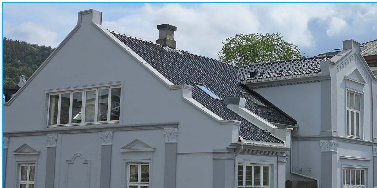
Tak mot nordvest. Foto: EIA
