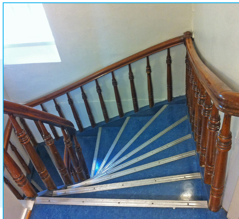
Synlige deler av den originale hovedtrappen mellom andre etasje og loft. Foto: EIA
