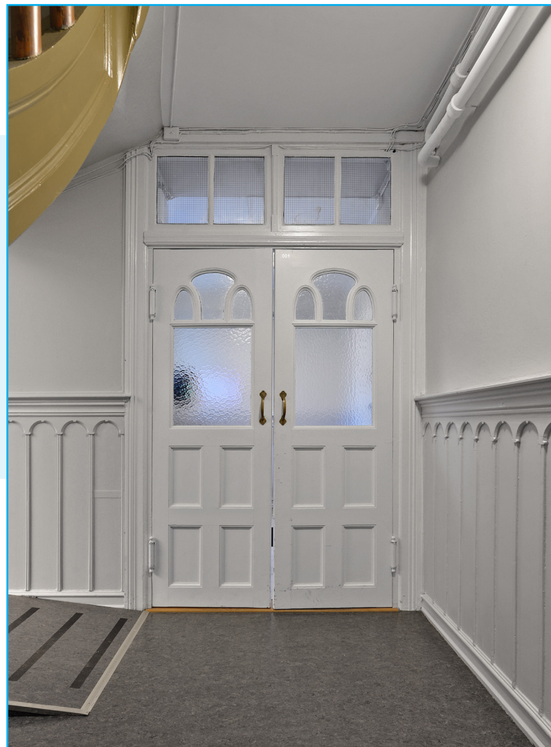
Hallen i første etasje har doble, originale dører fra 1909 i åpningen til den opprinnelige hovedinngangsdøren. Hallen har original brystning, trolig fra 1909. Foto: EIA
