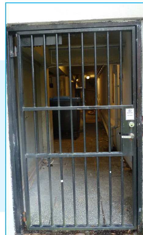
Det er støpt et betongdekke over utearealet mellom Muséplassen 1 og Christies gate 20. Dette er porten inn til de tekniske rommene under dette dekket.
