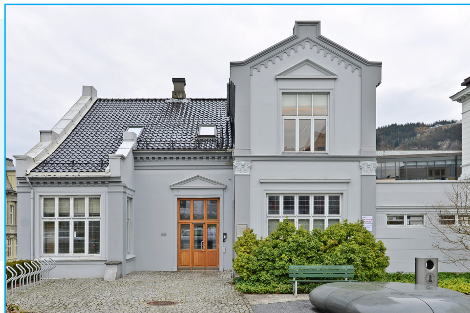
Fasade mot vest med ny, tilbakeført dør i hovedinngang. Foto: EIA
