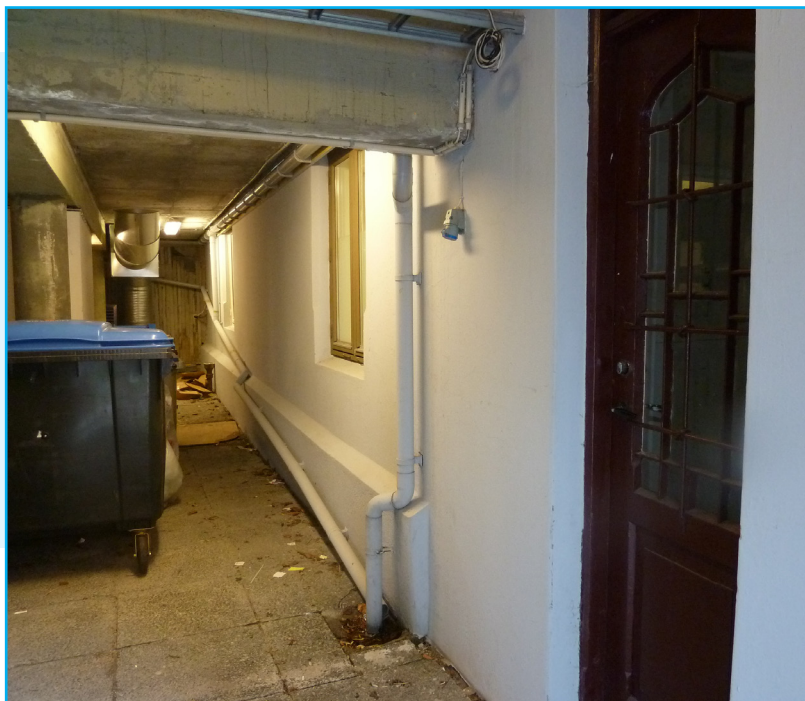
Nederste del av husets sørfasade er skjult under dekket som er bygget mellom Musé-plassen 1 og Christies gate 20. Kjellerens bidør fører ut til det overdekkede tekniske rommet. Foto: EIA
