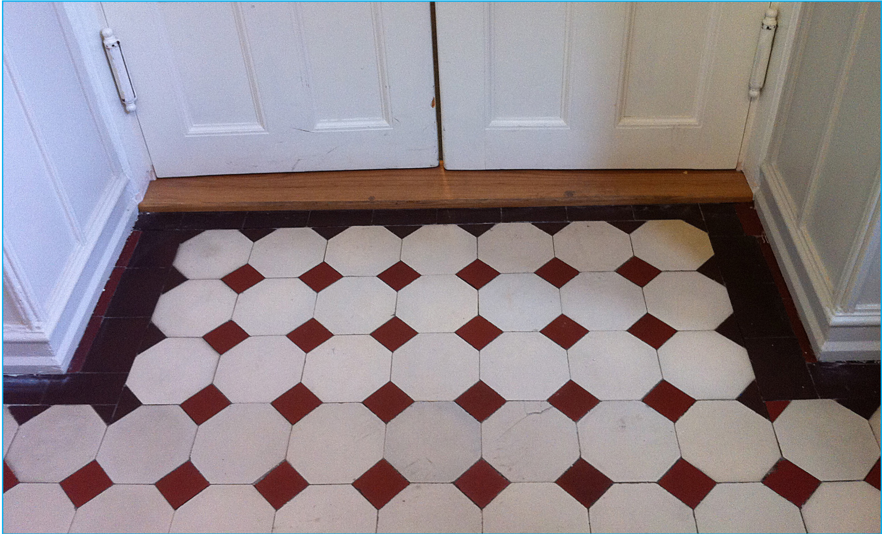
Flisene i vindfanget er originale fra 1909. Bildet viser også originalt panel, listverk og dørhengsler med knapp. Foto: EIA
