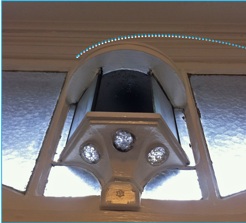
Lykten over hovedinngangsdøren i første etasje har jugendtrekk. Foto: EIA
