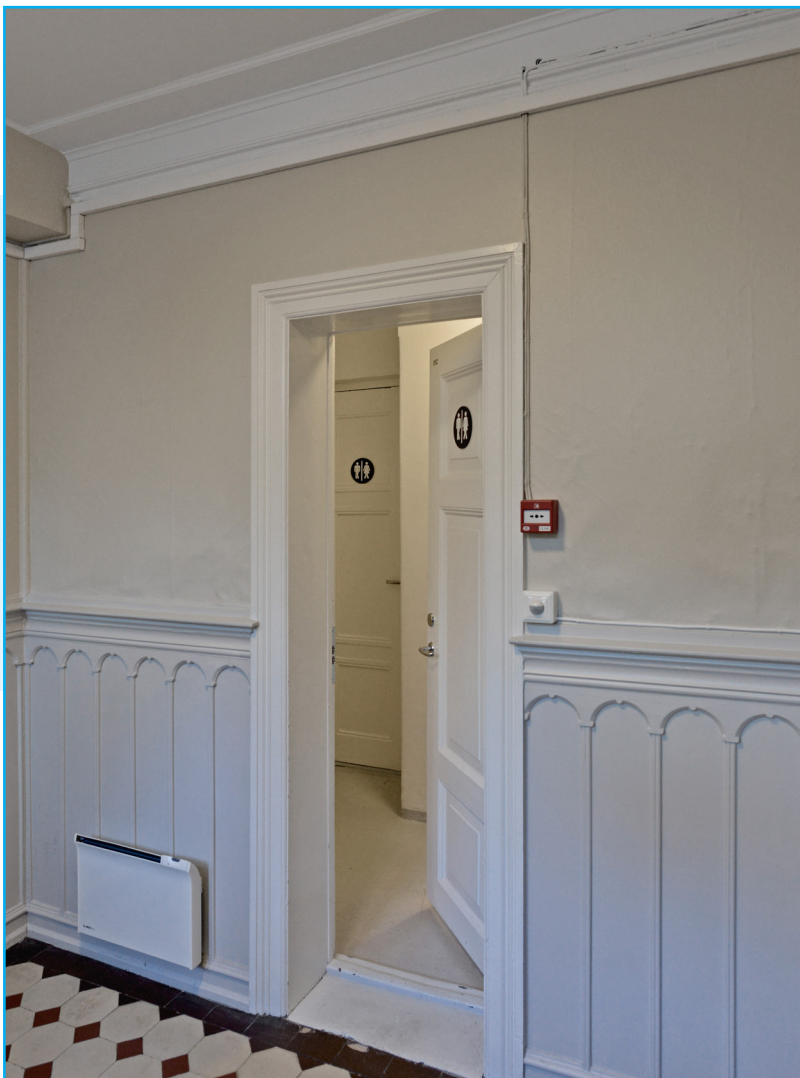
Originale dører til toalett ved vindfang i første etasje. Vindfanget har original, dekorert brystning fra 1909. Foto: EIA
