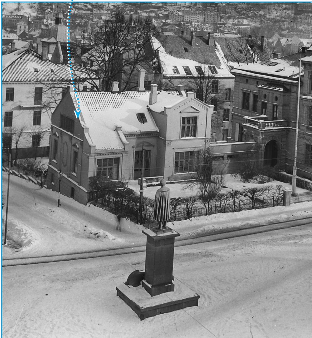
Fasade mot vest før 1968. Foto: Universitetsbiblioteket i Bergen
