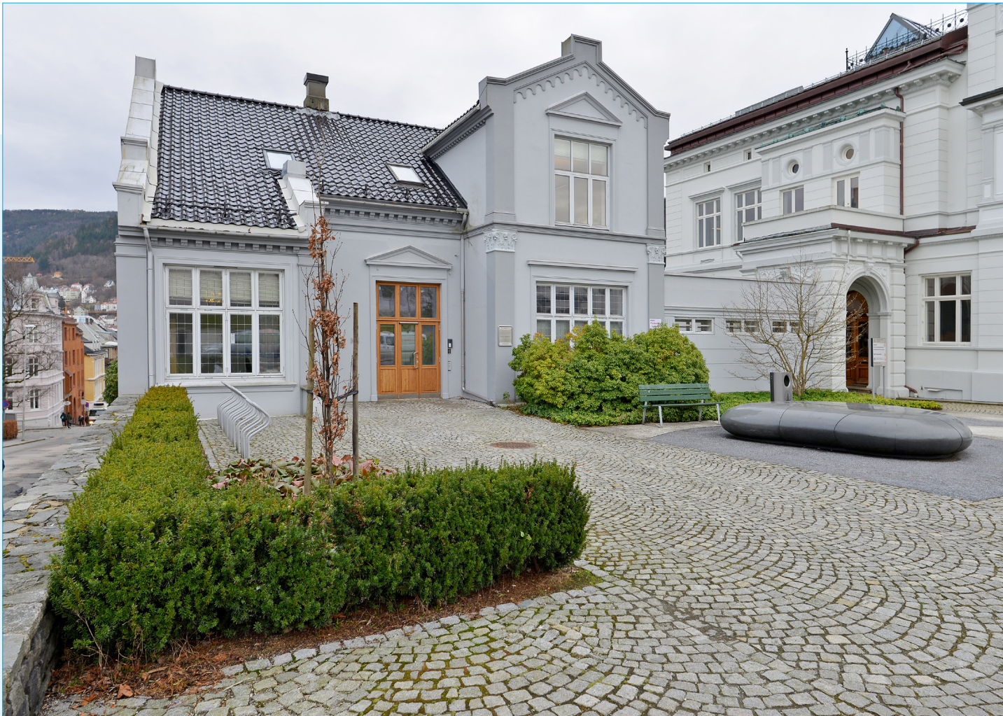
Da UiB overtok huset, ble det etablert ny hovedinngang mot vest. Den opprinnelige altanen ble omgjort til vindfang og huset fikk en moderne inngangsdør. Vindfanget ble fjernet i 2016 og det ble satt inn en ny dør i tilnærmet samme stil som opprinnelig altandør. Nytt vindfang er bygget i deler av hall. Foto: UiB
