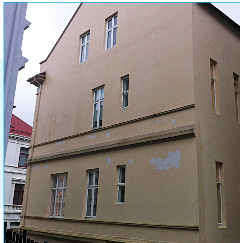
Rosenbergsgaten 39, fasade mot nord. Foto: EIA
