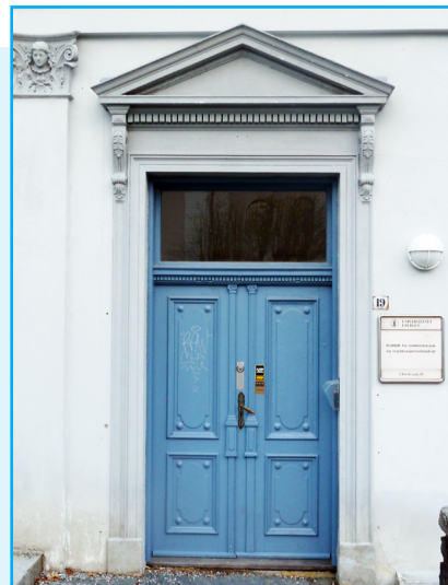
Inngangsdør til Christies gate 19. Foto: EIA
