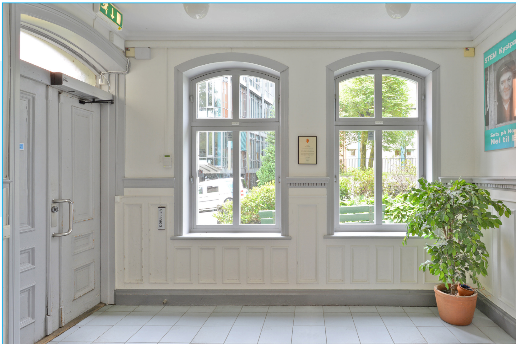
Original to-fløyet speildør med glassfelt over. Foto: EIA
