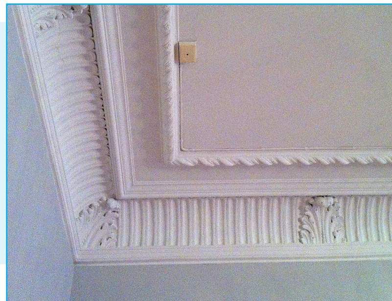
Detalj av himling i rom 15.104. Foto: EIA
