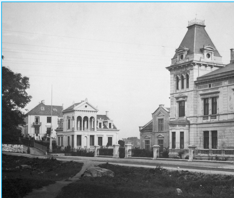
Fasade mot Christies gate (til venstre). Bildet viser villaen før ombyggingen i 1903. Her er huset uten Neptunskulpturen i veggnisje. Muséplassen 1 til høyre. Universitetsmuseets fotoarkiv
