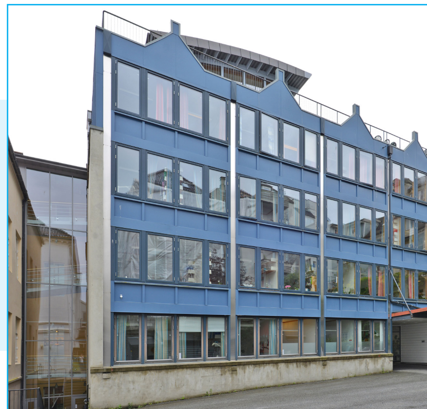
Christies gate 17 og 15, fasade mot nord. Foto: EIA
