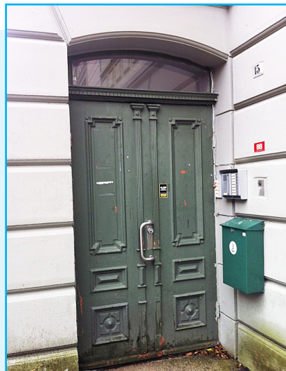
Inngangsdør til Christies gate 15. Foto: EIA
