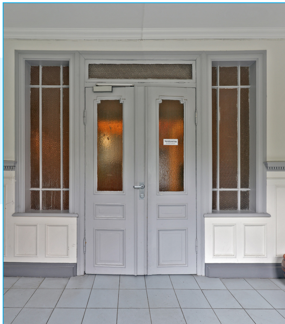
Original to-fløyet speildør med glassfelt over. Foto: EIA
