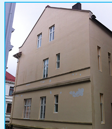
Fasade mot øst. Huset har felles vegg med nabo mot vest, Christies gate 15. Foto: EIA
