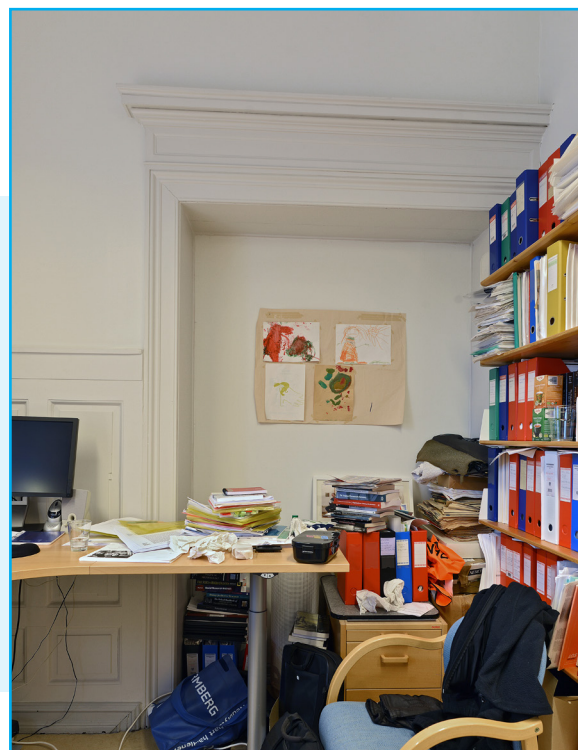
Brystning på vegg og gjenmurt døråpning med originale listverk i rom 19.113. Foto: EIA
