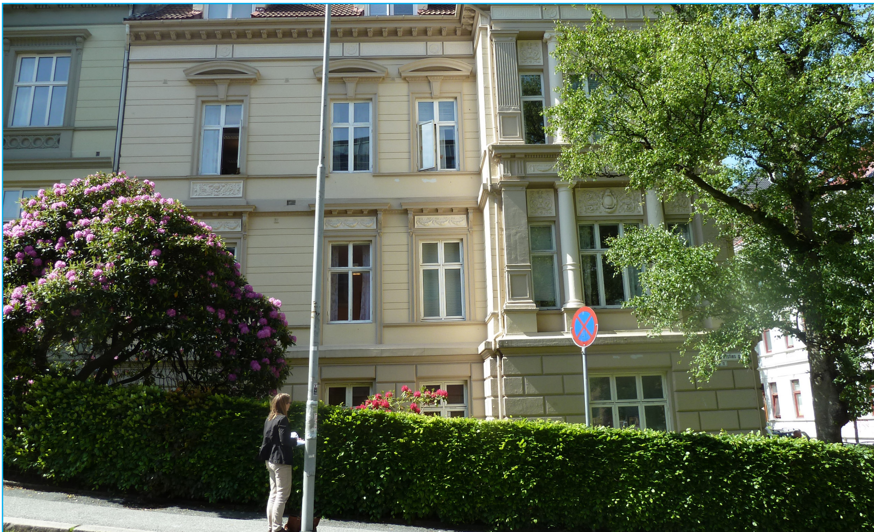
Hagen utenfor Rosenbergsgaten 39 ut mot Christies gate. Foto: EIA
