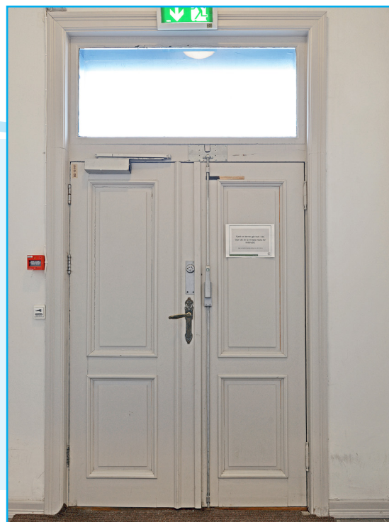
Original to-fløyet ytterdør med overlys. Foto: EIA
