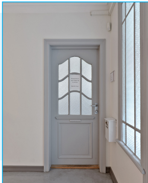
Christies gate 15, fyllingsdør i rom 15.002. Foto: EIA
