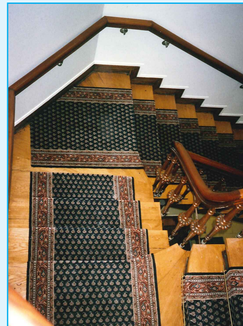
Hovedtrapp etter restaurering i 1996/1997. Den originale hovedtrappen er bevart i Christies gate 17. I nabohusene er hovedtrappen fjernet eller bygget kraftig om. Foto: EIA
