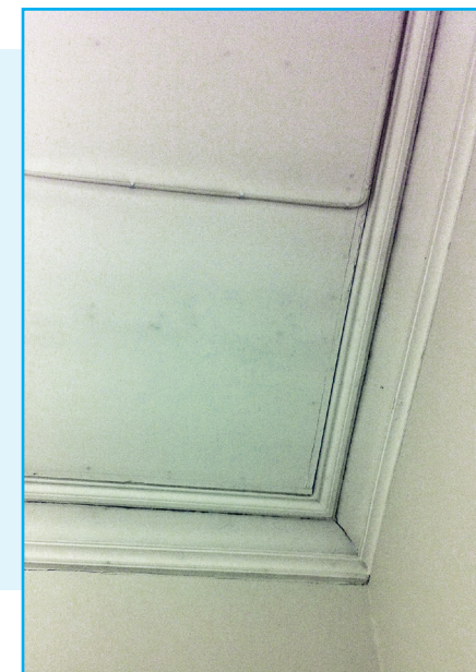
Rom 15.303 Detalj tak. Foto: EIA
