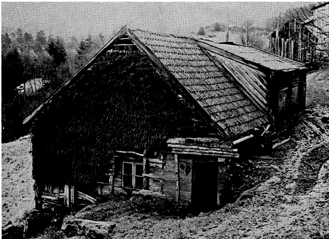
Fig. 78. Smørdal, Lindås. Flor med brakekledning som isolasjon utanpå tømmeret.
