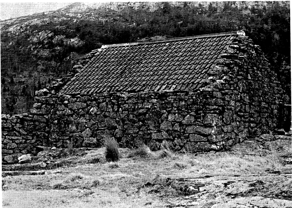
Fig. 62. Isdal, Lindås. Gardflor i grensa inn/utmark. Steingarden utgjer eine vegg i gardflore. Sjå fig. 61.
