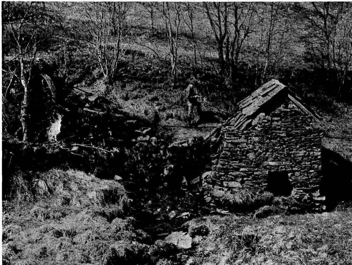
Fig. 68. Eikeland, Lindås. Kvernhus med mur i gavl og sidevegg.
