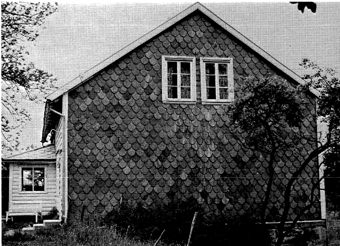
Fig. 54. Kvalvåg, Lindås. Bustadhus med gavlveggen kledd med takskifer til vern mot drev.
