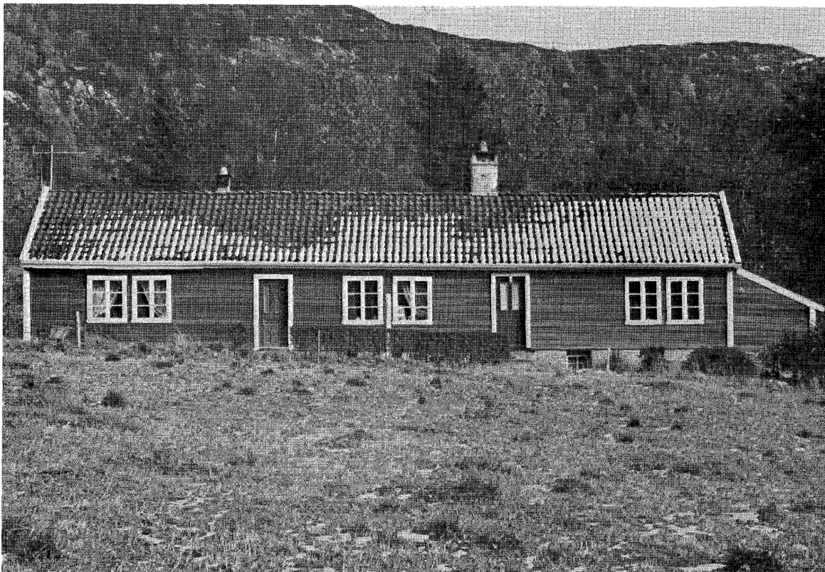
Fig. 33. Isdal, Lindås. Samanbyggt hus med symmetrisk fasade.
