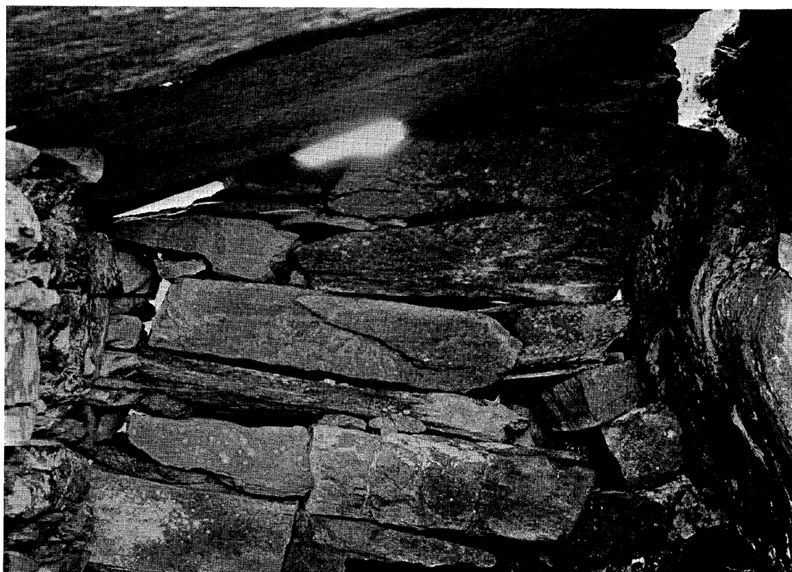
Fig. 72. Eikeland, Lindås. Sauehus i utmark. Merk dei massive steinhellene. Sjå fig. 70.
