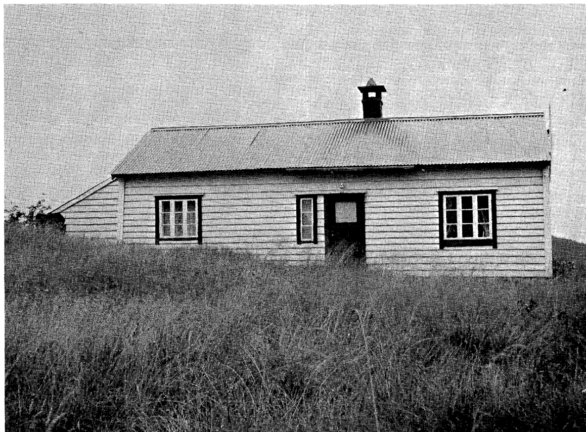
Fig. 22. Lindås, Lindås. Stove av midtgangstypen. I Nordhordland var det vanlig med skut på den eine eller begge kortsidene av huset.
