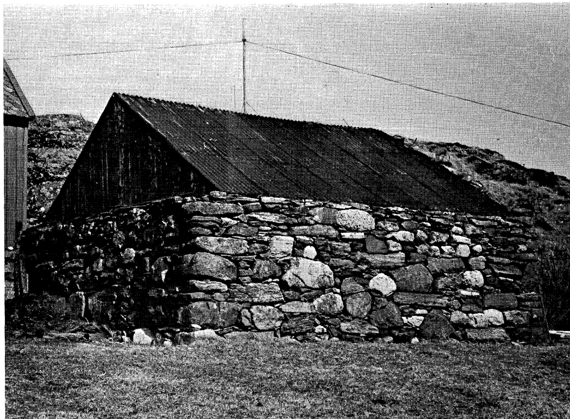
Fig. 59. Utsylta, Radøy. Eldhus. Veggene er mura og gavlane i reisverk.
